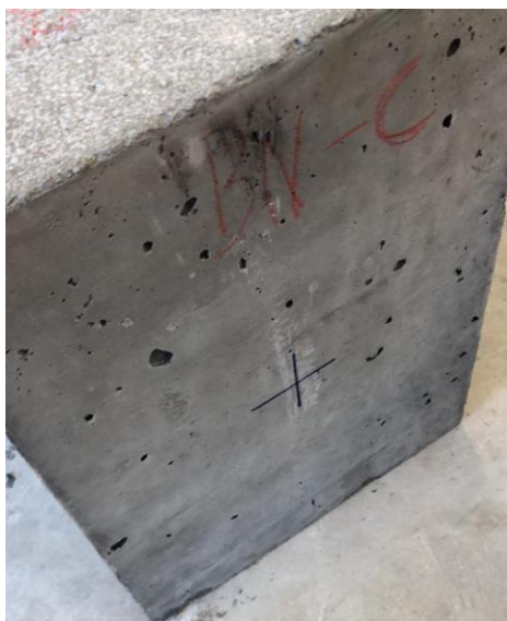
Figura 40 - Bloco marcado para realização da perfuração.
