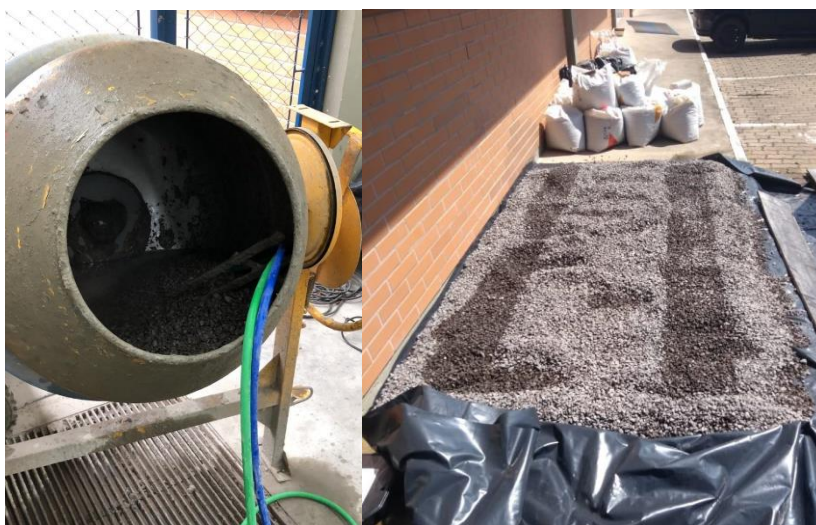
Figura 31 - Figura da esquerda mostra a lavagem da brita e na direita a secagem ao sol.
