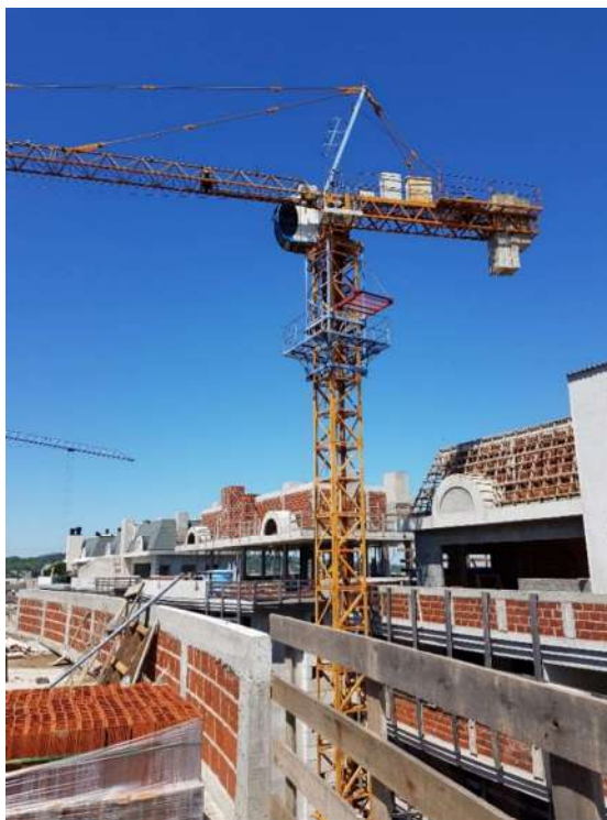
Figura 53 - Grua Obra B
