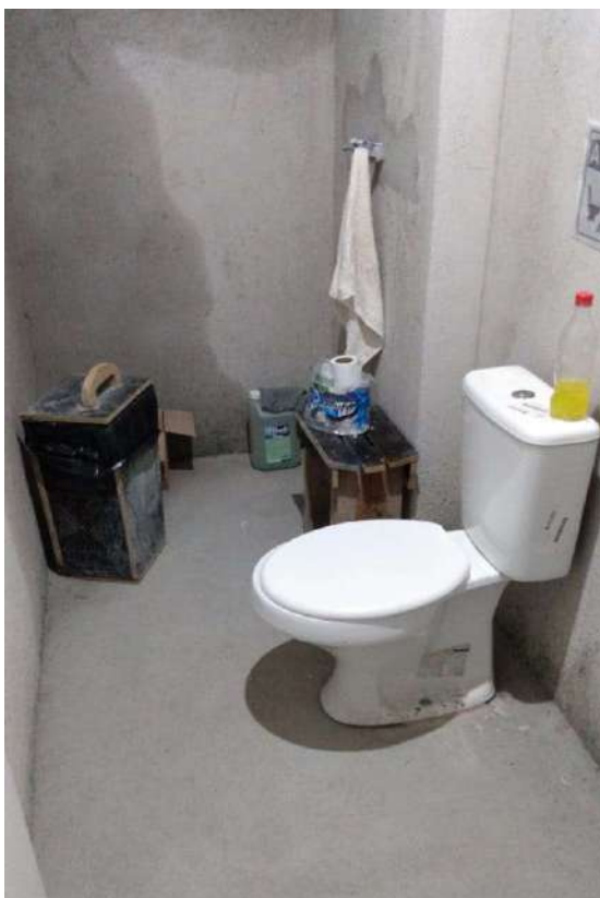
Figura 7 - Instalações sanitárias femininas Obra B
