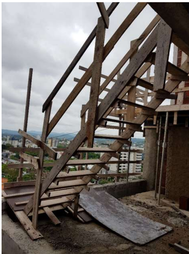
Figura 42 - Escada provisória Obra C
