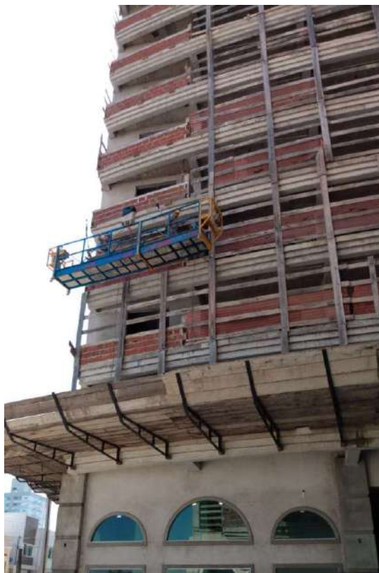
Figura 57 - Andaime suspenso Obra B
