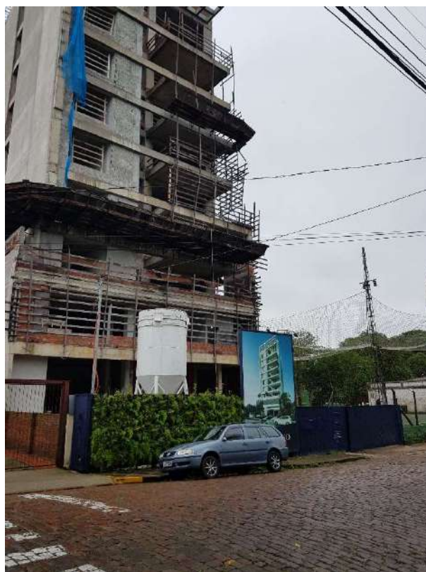
Figura 90 - Tapumes Obra C
