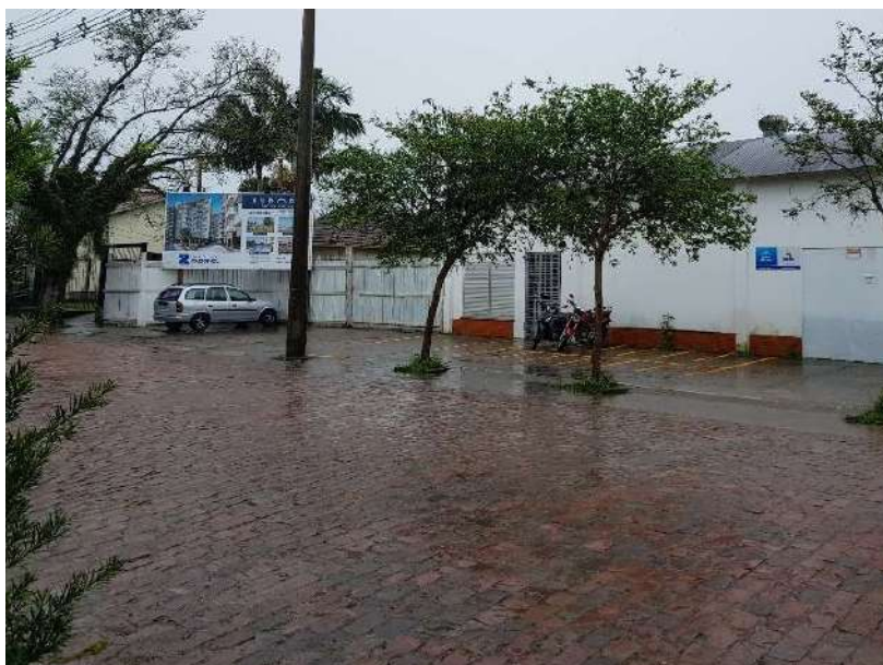
Figura 87 - Barreira em tapumes na Obra A
