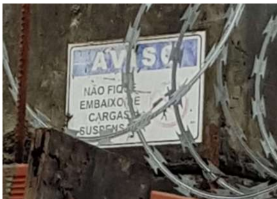
Figura 52 - Placa de sinalização na grua da Obra A
