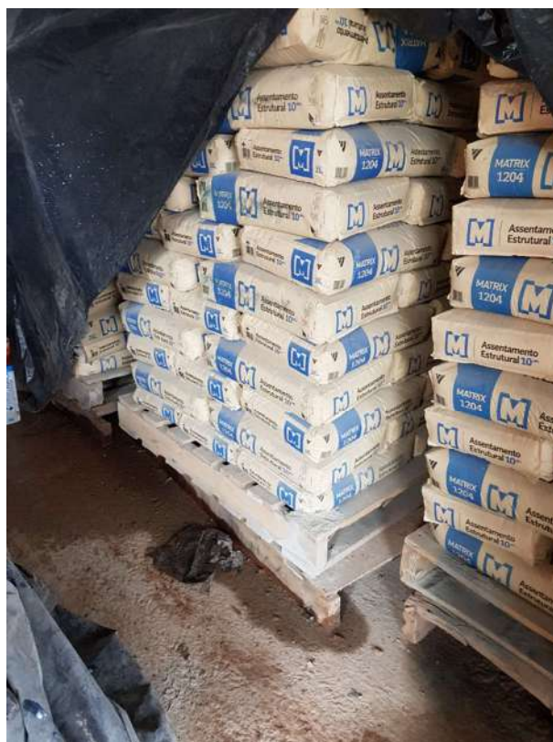
Figura 70 - Estocagem da argamassa de assentamento na Obra A
