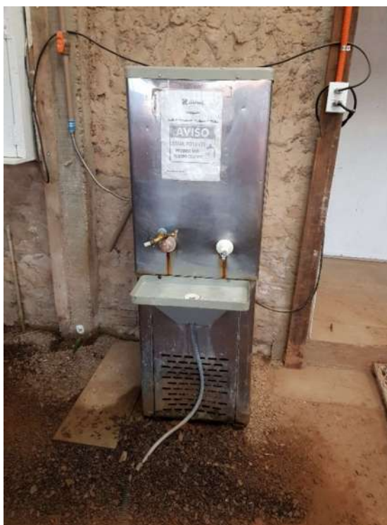
Figura 24 - Bebedouro Obra A
