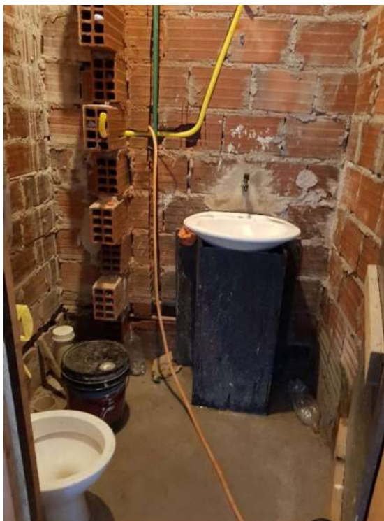
Figura 8 - Instalações sanitárias Obra C
