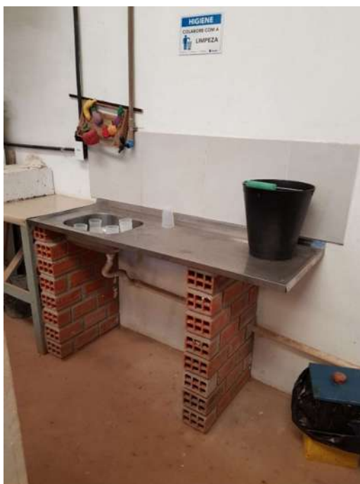
Figura 22 - Lavatório Obra A
