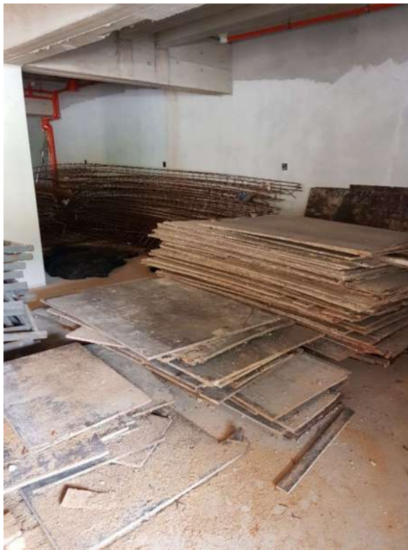
Figura 76 - Madeiras para reutilização da Obra C
