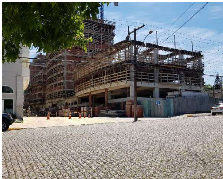
Figura 89 - Tapume na outra lateral da Obra B
