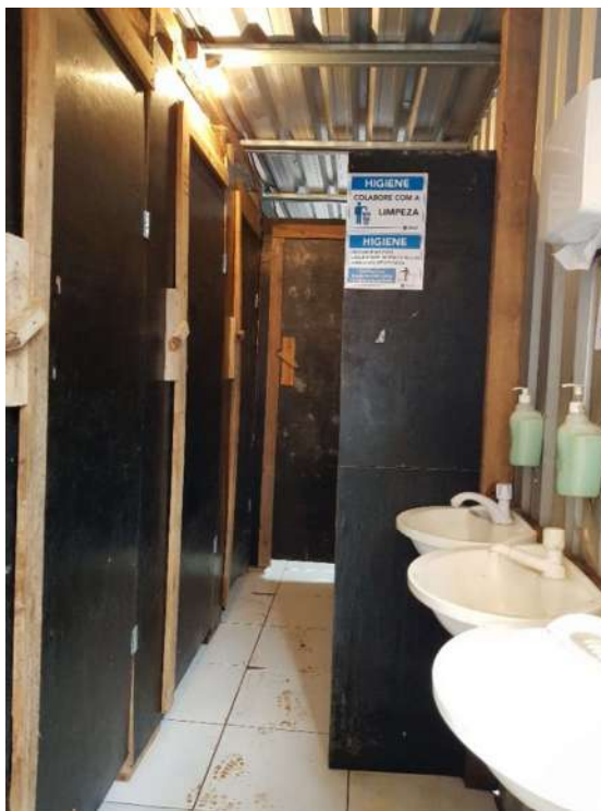
Figura 4 - Instalações sanitárias masculinas Obra A
