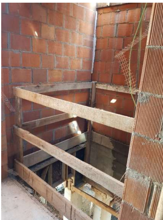
Figura 43 - Fechamento poço do elevador Obra A
