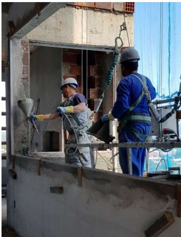
Figura 64 - Utilização do cinto de segurança com trava-queadas na Obra C
