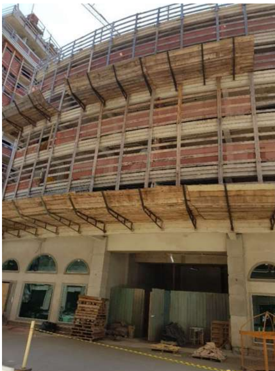
Figura 47 - Plataforma principal e secundária e sistema de guarda-corpo Obra B
