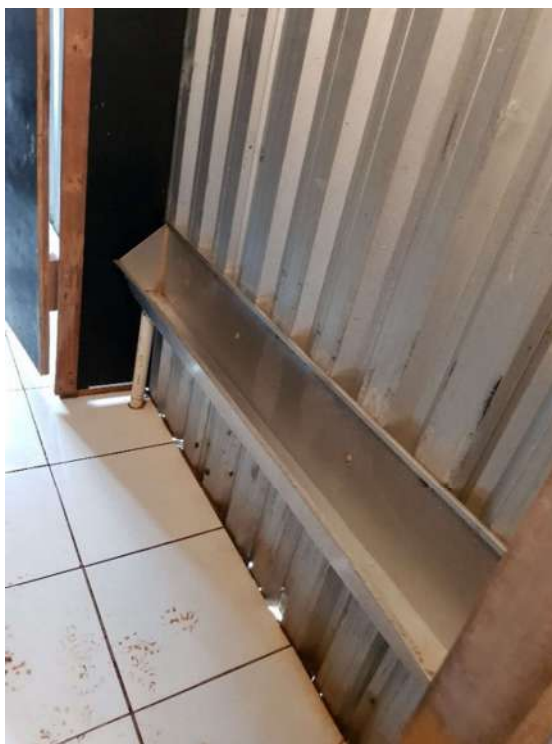
Figura 11 - Mictório Obra A
