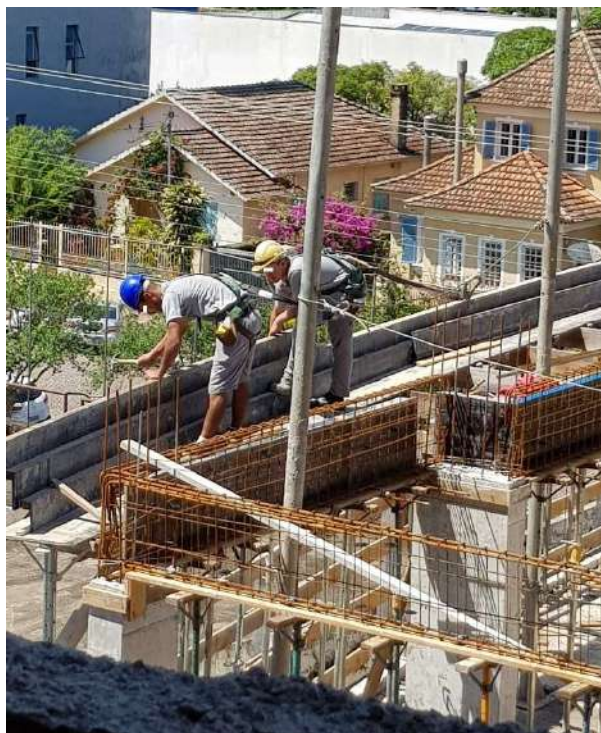
Figura 63 - Utilização do cinto de segurança com trava-quedas na Obra B
