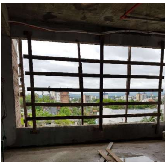
Figura 48 - Sistema de guarda-corpo Obra C
