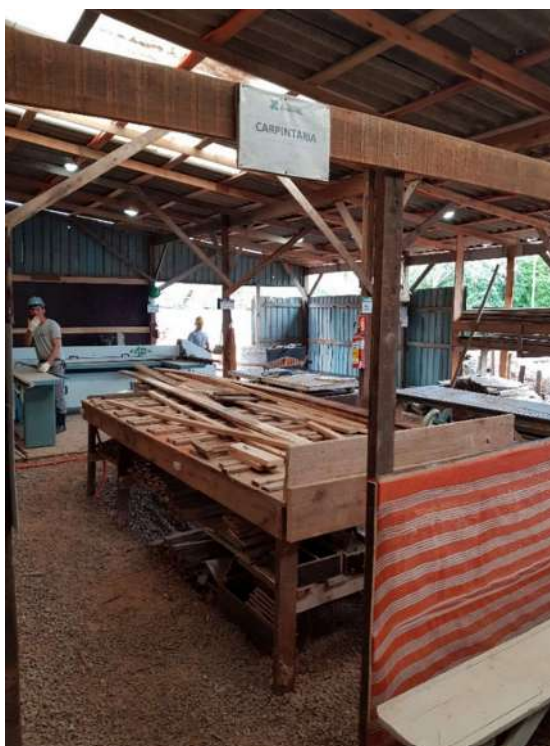
Figura 33 - Área da carpintaria Obra A
