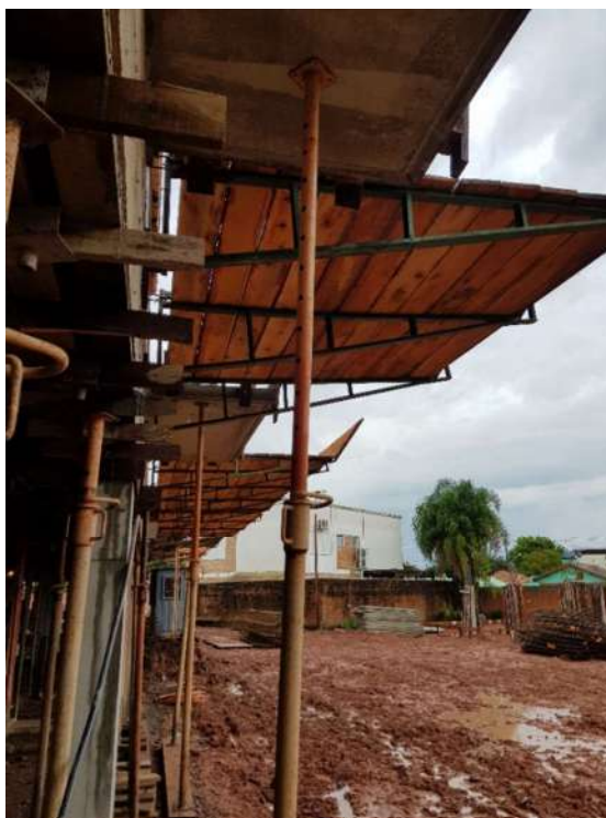
Figura 46 - Plataforma principal Obra A
