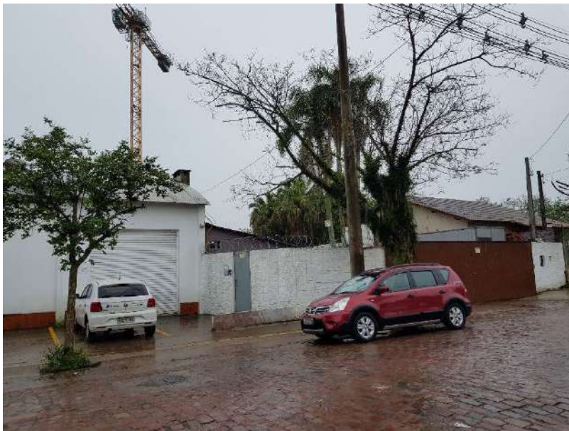
Figura 86 - Barreira em alvenaria da Obra A
