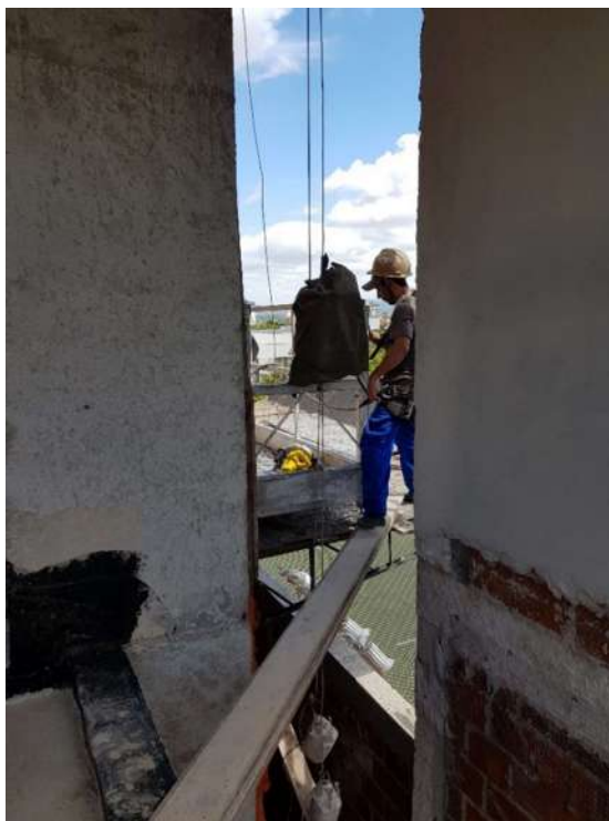
Figura 60 - Madeiras para a travessia da edificação até a bandeja na Obra C
