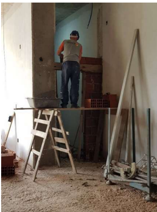
Figura 59 - Andaime para uso interno na Obra C
