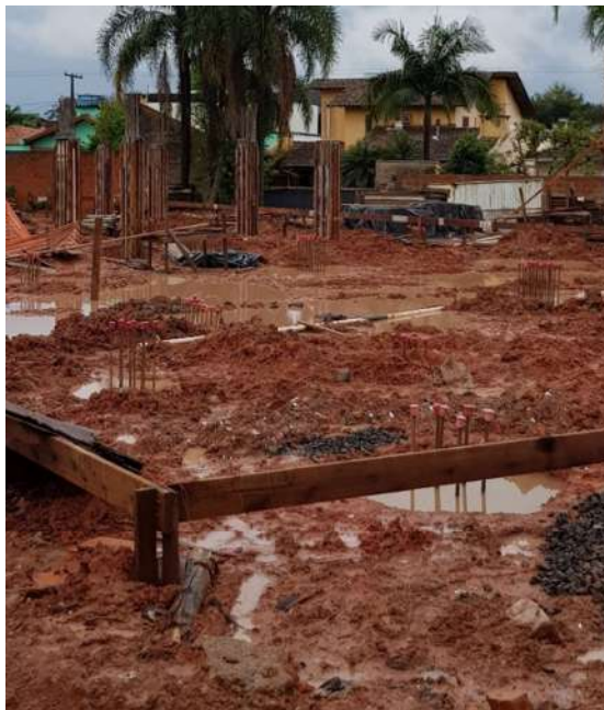
Figura 36 - Vergalhões de aço com ponteiras na Obra A
