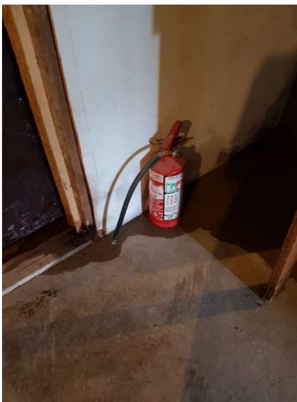
Figura 79 - Extintor de incêndio Obra C
