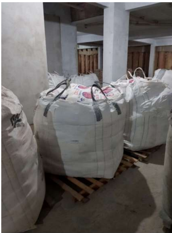
Figura 71 - Estocagem da cal virgem na Obra B
