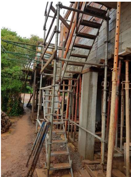
Figura 39 - Escada provisória Obra A
