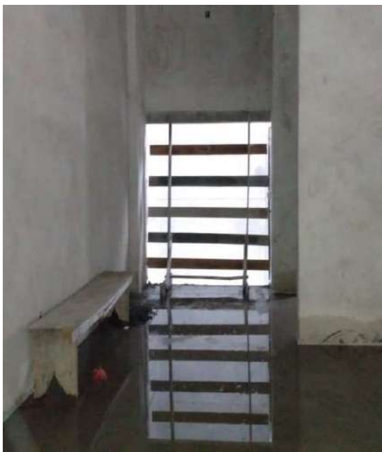
Figura 44 - Fechamento poço do elevador Obra B
