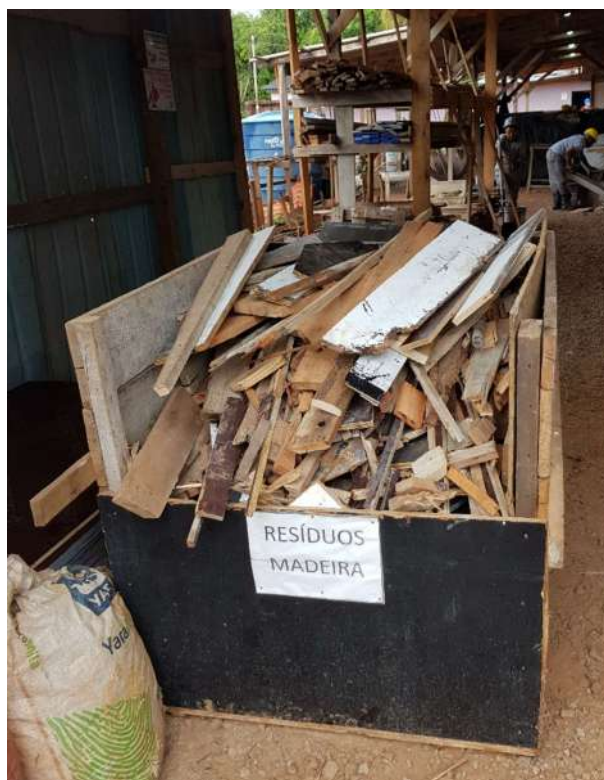
Figura 74 - Madeiras para descarte da Obra A
