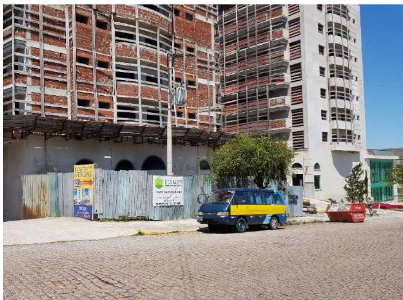
Figura 88 – Tapumes em um lateral da Obra B
