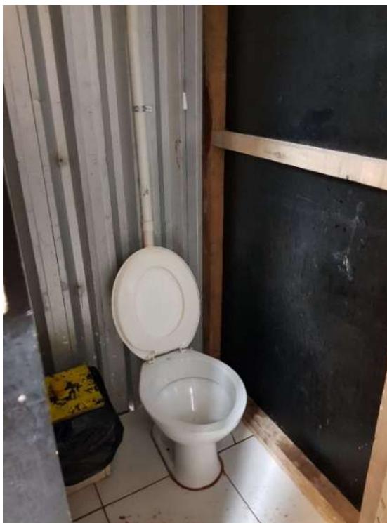
Figura 9 - Gabinete sanitário masculino Obra A
