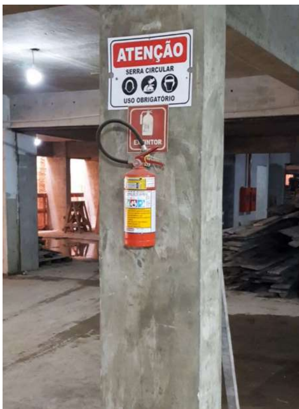
Figura 78 - Extintor de incêndio Obra B
