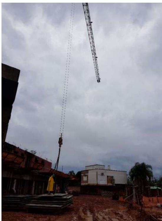
Figura 50 - Grua Obra A
