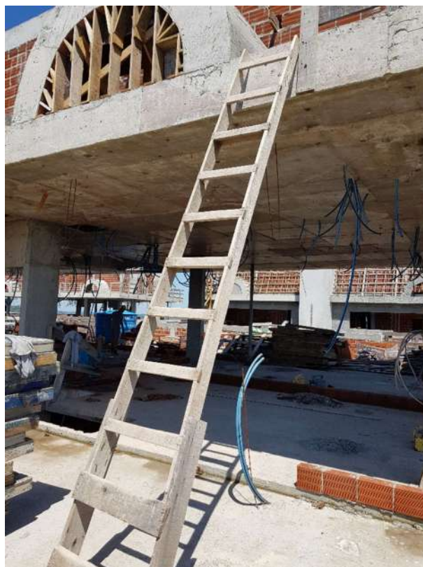
Figura 40 - Escada de mão Obra B
