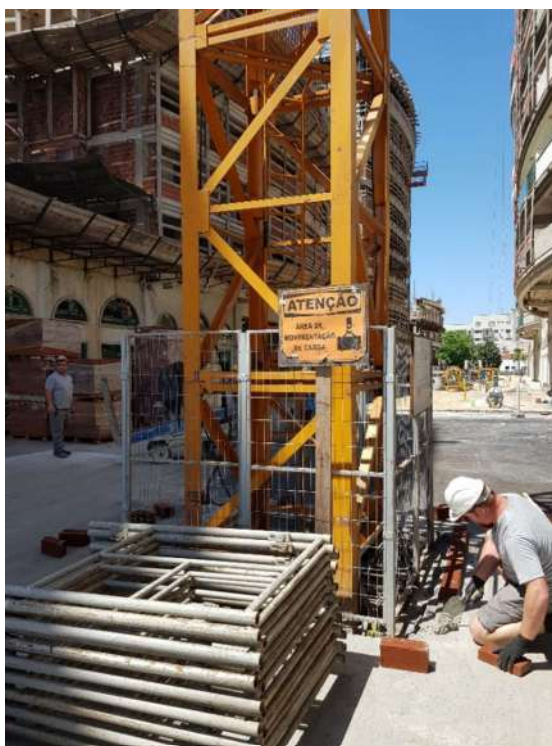
Figura 54 - Lastro da grua da Obra B
