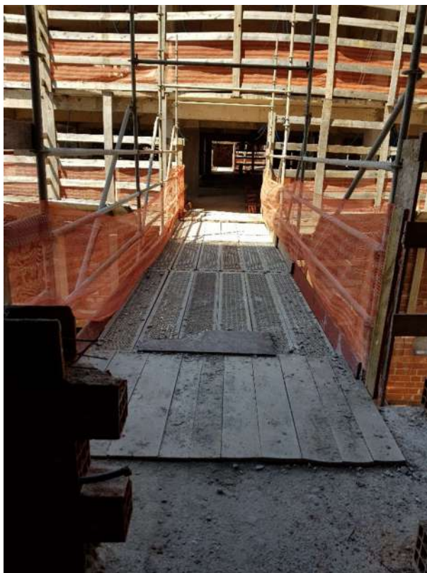
Figura 41 - Passarela Obra B
