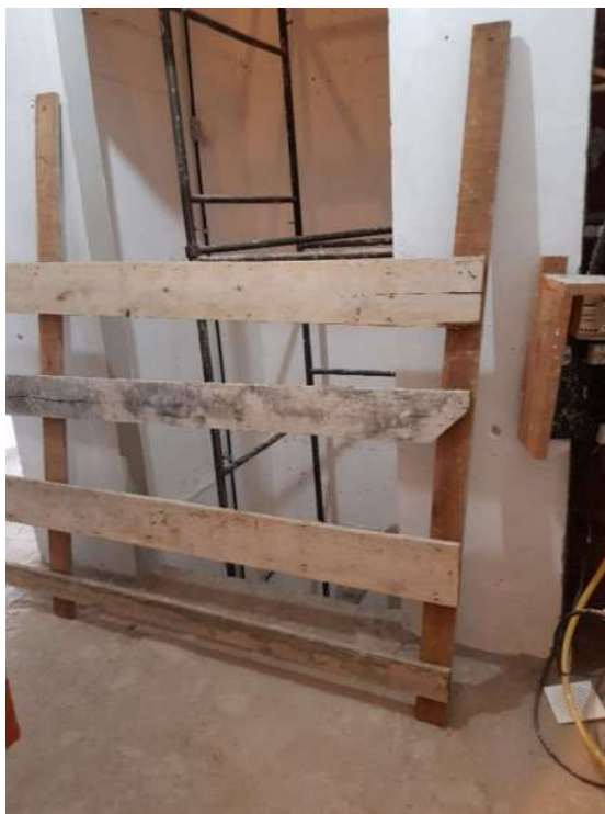
Figura 45 - Fechamento poço do elevador Obra C
