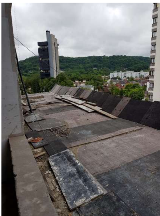
Figura 49 - Plataforma principal Obra C
