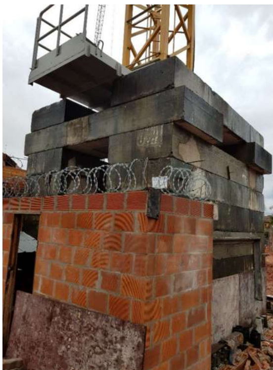
Figura 51 - Lastro da grua da Obra A
