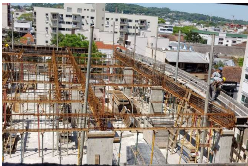
Figura 37 - Vergalhões de aço sem ponteiras na Obra B
