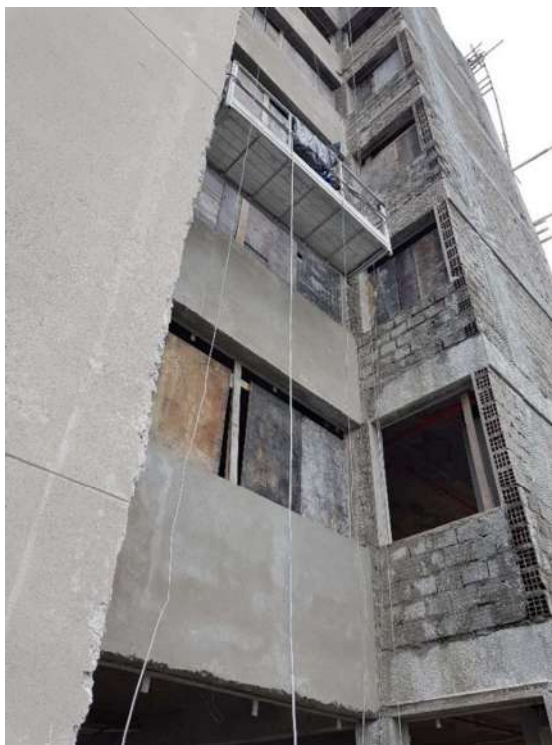
Figura 58 - Andaime suspenso Obra C
