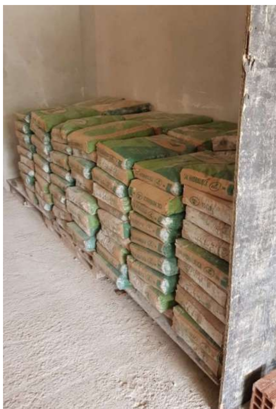
Figura 72 - Estocagem da cal hidratada na Obra C
