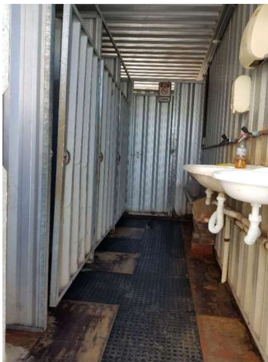
Figura 5 - Instalações sanitárias masculinas Obra B
