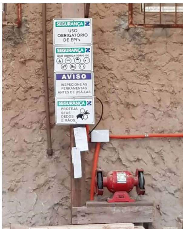
Figura 82 - Placas orientando o uso de EPIs na Obra A
