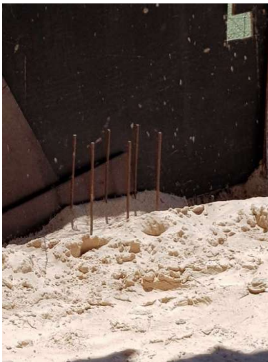
Figura 38 - Vergalhões de aço sem ponteiras na Obra C
