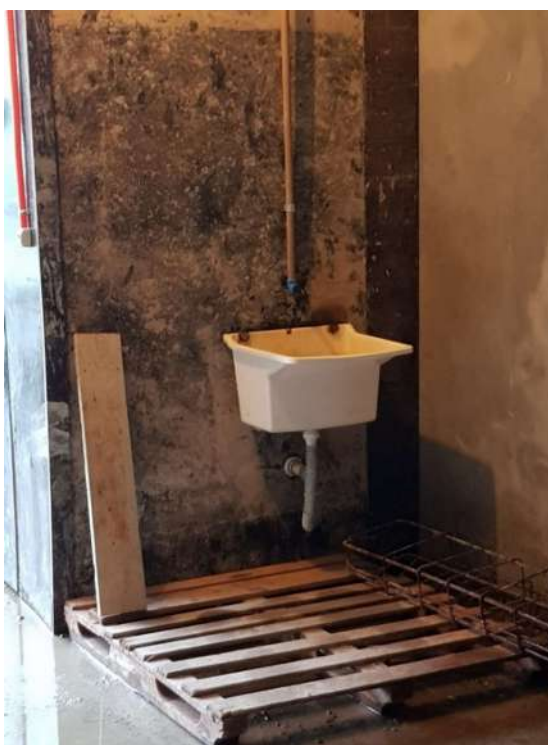
Figura 30 - Lavatório Obra C
