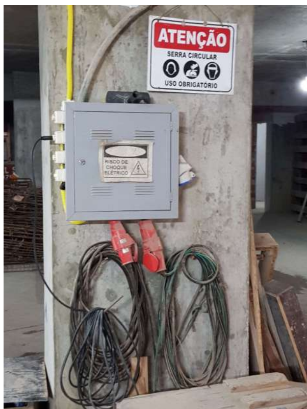
Figura 84 - Placa exigindo o uso de EPIs na serra circular na Obra B
