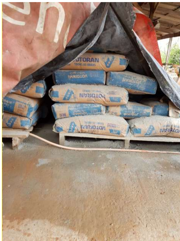
Figura 69 - Estocagem do cimento Obra A
