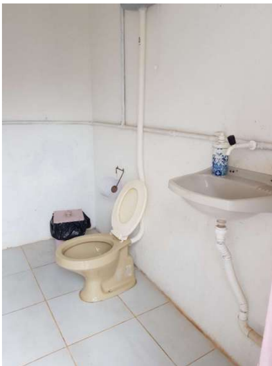
Figura 6 - Instalações sanitárias femininas Obra A
