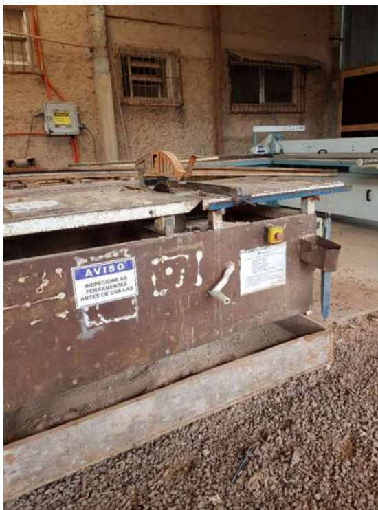
Figura 32 - Serra circular Obra A
