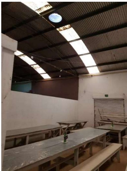
Figura 21 - Refeitório Obra A
