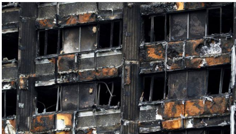
Figura 19 - Detalhe do revestimento após o incêndio
