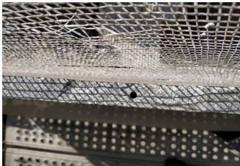
Figura 86 - Furação das peças para o encaixe na fixação
