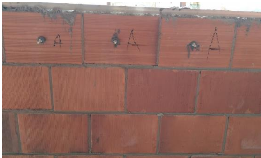
Figura 80 - Chumbadores fixados em blocos canaleta grauteados em empreendimento de alvenaria estrutural
