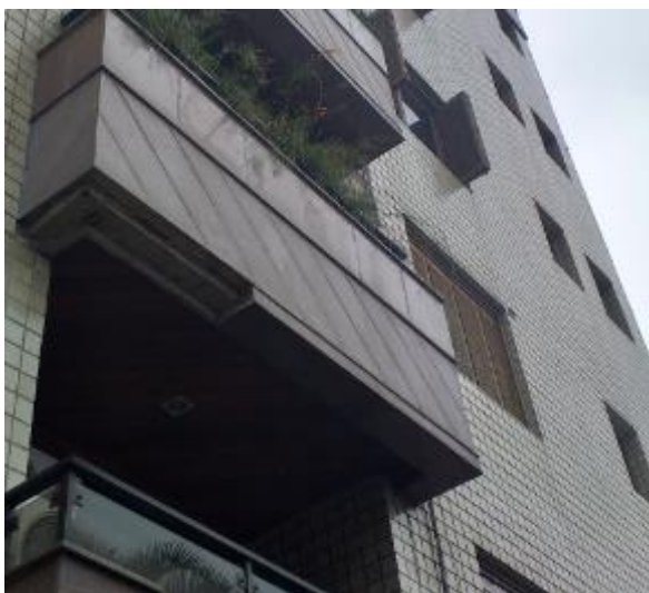
Figura 93- Desprendimento de placa em condomínio residencial de Porto Alegre
