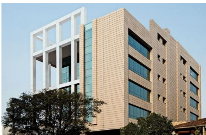
Figura 7 - Edifício Brigadeiro, em São Paulo, com fachadas ventiladas NBK
