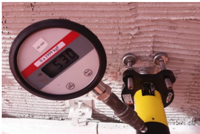
Figura 81 - Equipamento para a realização do ensaio de arrancamento
