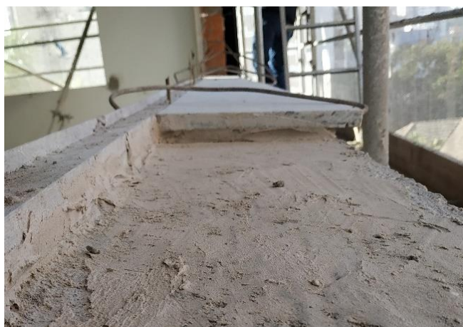
Figura 90 - Visualização da instalação da pingadeira inferior sobre o substrato
