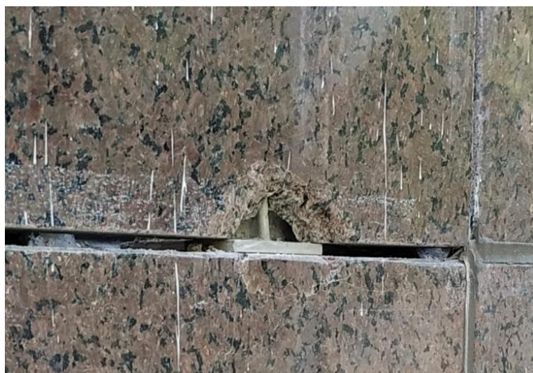
Figura 91 - Defeito verificado em peça que virá a ser substituída
