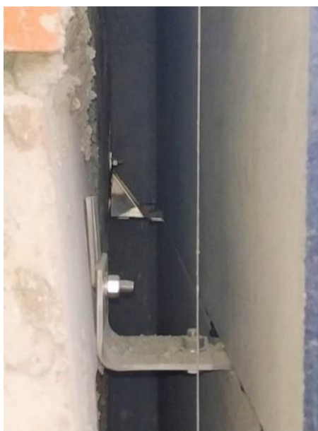
Figura 85 - Detalhe da ancoragem
