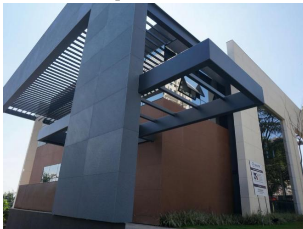
Figura 8 - Sede do SINAFER-SP após reforma com fachada ventilada da ULMA
