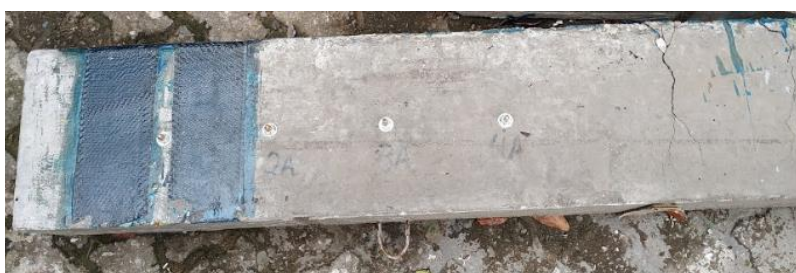
Figura 79 - Chumbadores fixados em viga de concreto armado C30
