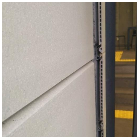
Figura 14 - Visualização das ancoragens do revestimento da fachada da UNISINOS
