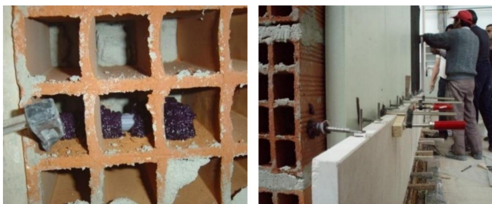
Figura 23 - Detalhe da interface entre o gato de fixação, camisa e resina com a alvenaria
