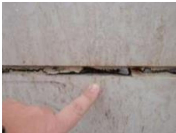
Figura 27 - Defeito apresentado pelo fechamento das juntas com mastique
