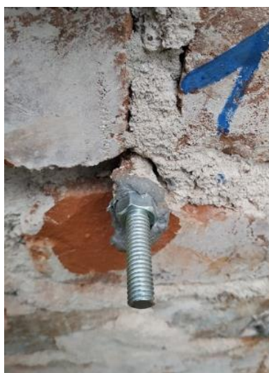
Figura 106 – Ruptura na junta de argamassa após a realização do teste de arrancamento do chumbador. (%)
