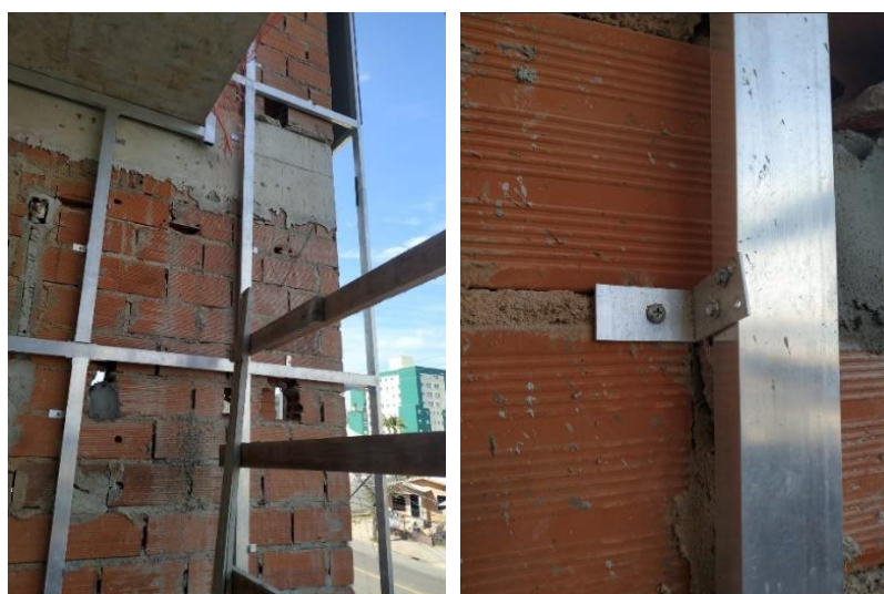
Figura 96 - Solução adotada de fixação da subestrutura metálica da fachada nas juntas de argamassa de assentamento
