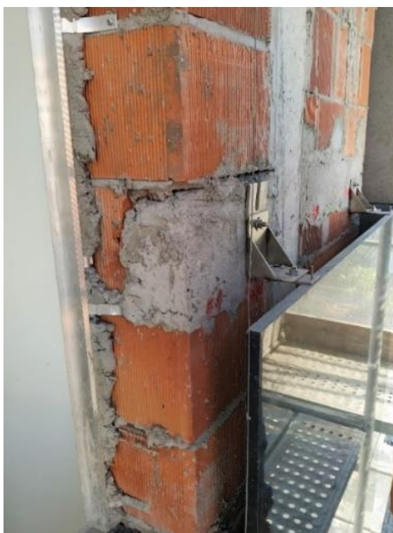
Figura 84 - Revestimento em processo de fixação
