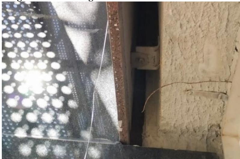
Figura 88 – Ancoragem descontínua no tardo da rocha
