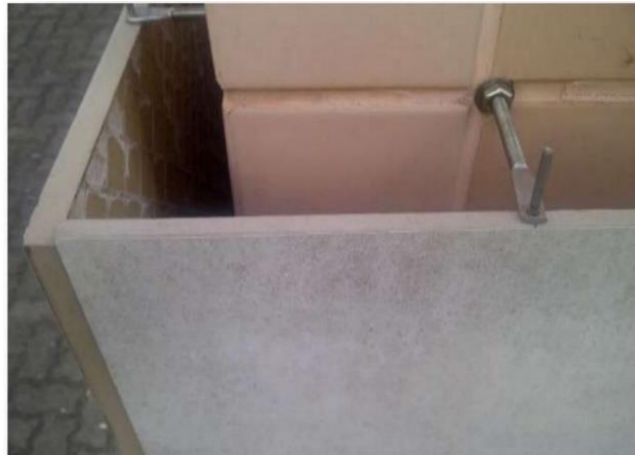
Figura 39 - Placas fixadas com ancoragens pontuais diretamente sobre a alvenaria
