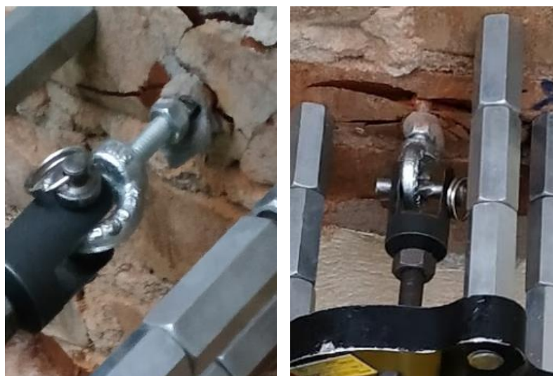
Figura 105 - Ruptura do substrato de tijolo maciço, com formação de cone de ruptura
