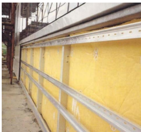
Figura 24 - Isolamento térmico com manta de fibra de vidro em fachada ventilada
