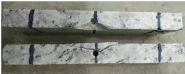
Figura 100 - Ruptura por tração da seção abaixo do furo
