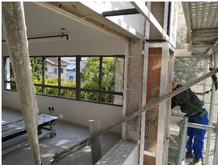
Figura 92 - Subestrutura auxiliar para a fixação do ACM
