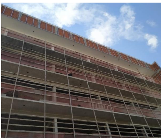
Figura 95 - Empreendimento comercial com fachada não aderida de ACM em execução em Santa Cruz do Sul
