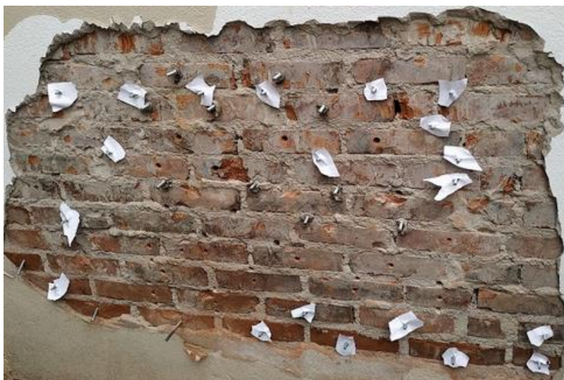
Figura 78 – Chumbadores em processo de fixação em furos nos tijolos e nas juntas de argamassa
