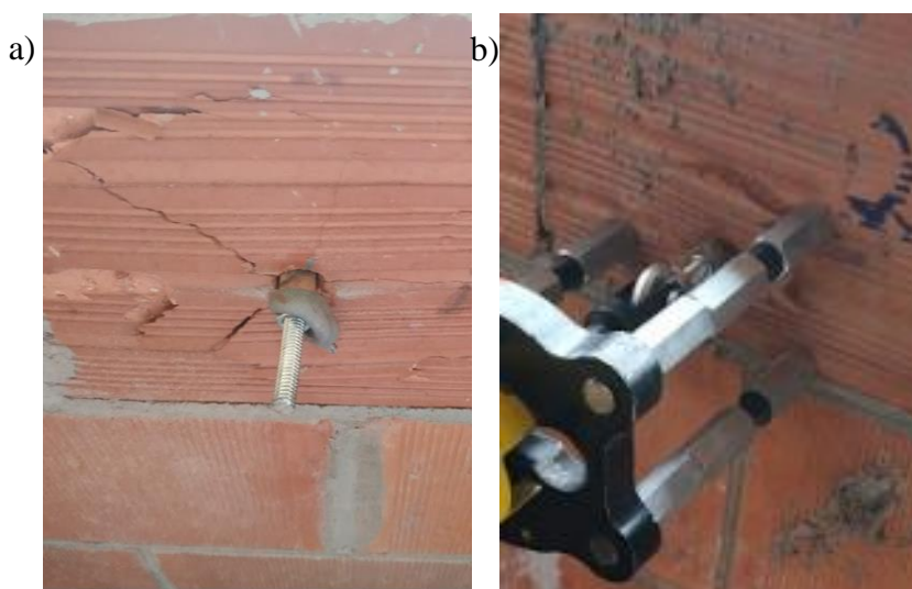
Figura 104 - Ruptura do substrato em alvenaria estrutural com fissuras radiais (a) e cone de ruptura (b)
