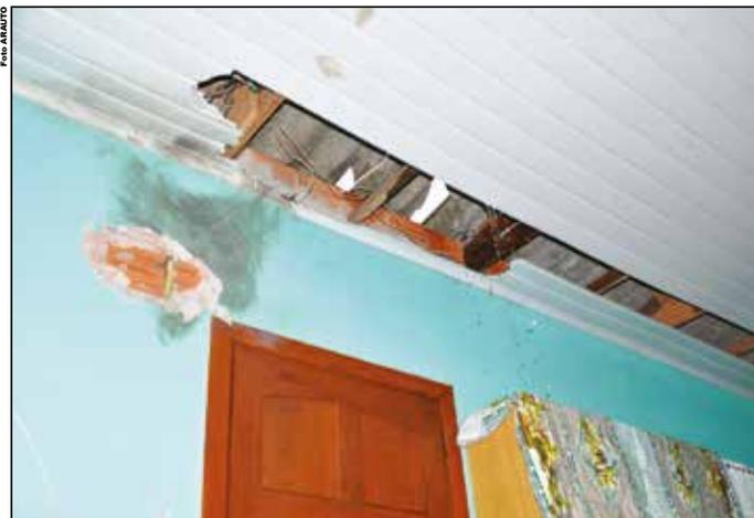
A descarga foi em uma antena de TV. Na casa, houve estragos no telhado, no forro e na parede
