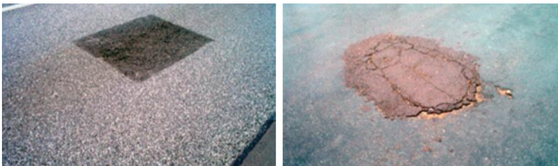
Figura 14: Remendo profundo e superficial, respectivamente
