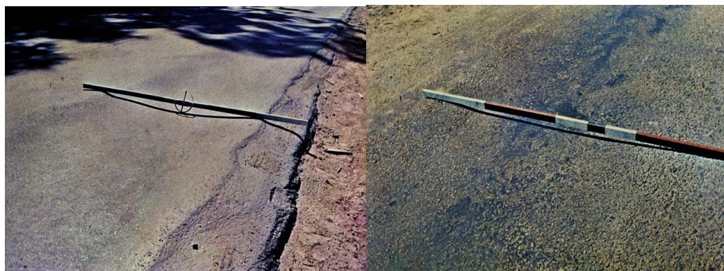
Figura 8: Afundamento por “Trilha de Roda” e afundamento local
