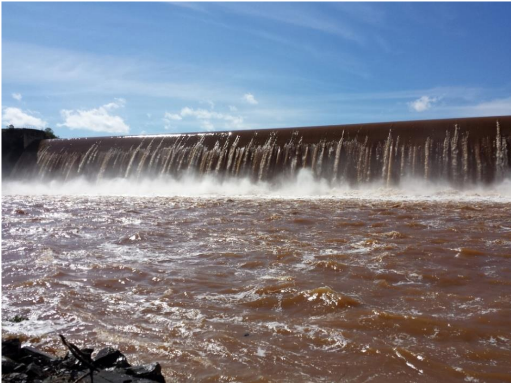
Figura 13 - UHE Quebra Queixo – Rio Chapecó – São Domingos (SC)
