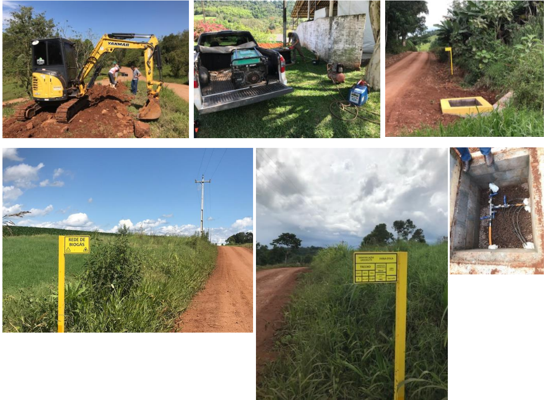
Figura 29 – Sinalização Gasoduto e cabos de fibra ótica
