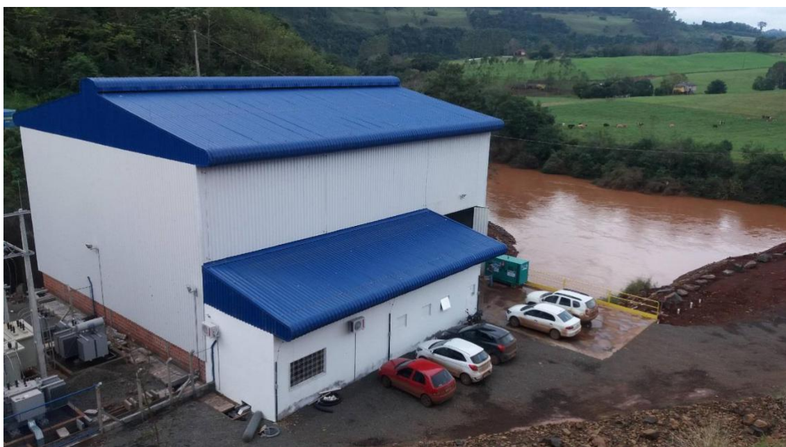
Figura 52 - PCH Coração – Águas Frias – SC
