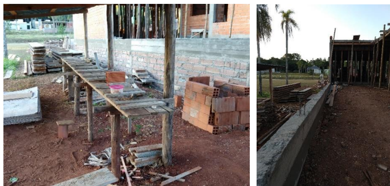
Fotografia 8: Armações de aço
