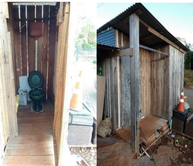
Fotografia 2: Instalações sanitárias da obra 1
