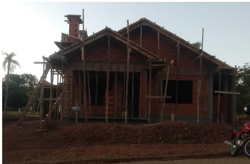
Fotografia 1: Fachada sem tapumes
