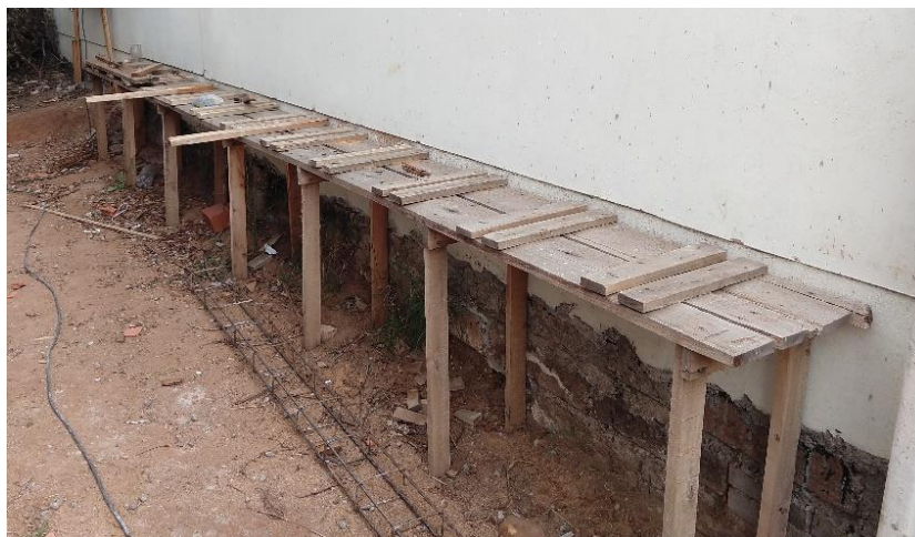
Fotografia 13: Bancada de corte e dobra de aço da obra 2
