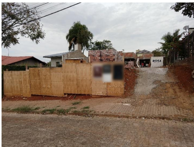
Fotografia 10: Tapumes na entrada da obra
