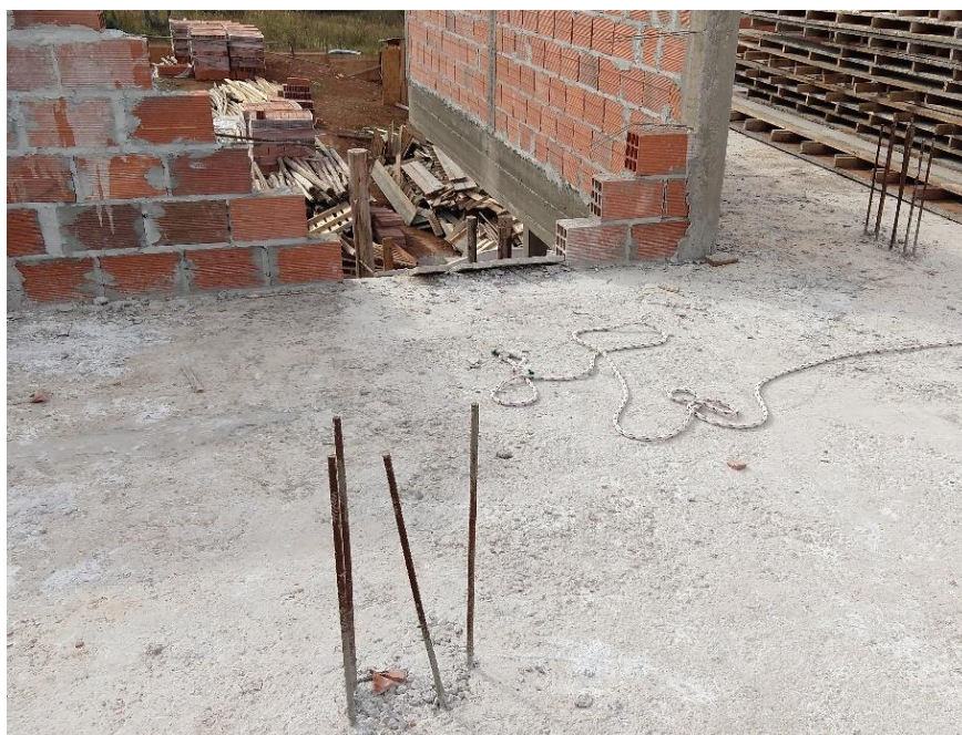
Fotografia 14: Pontas verticais de vergalhões de aço
