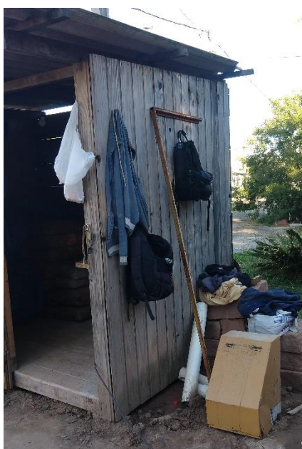
Fotografia 19: Vestiários da obra 3
