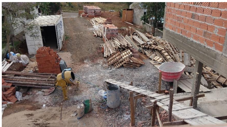
Fotografia 16: Ordem e limpeza do canteiro
