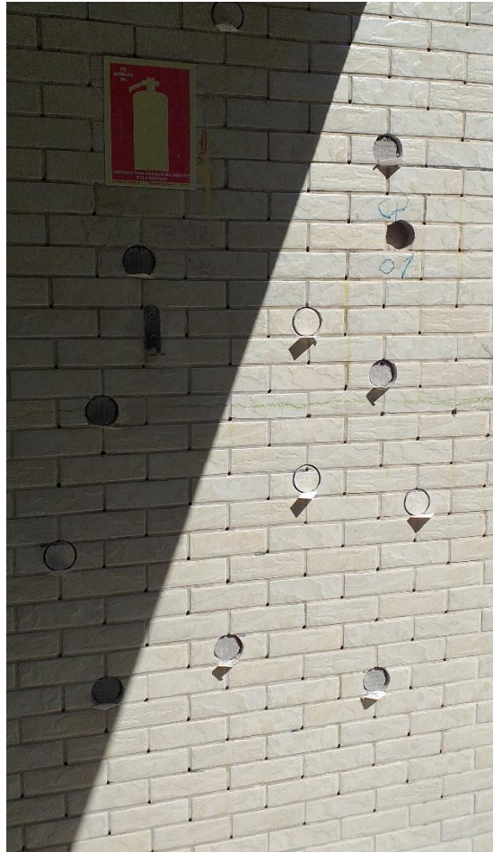
Figura 75 - Ensaio de arrancamento protótipo D
