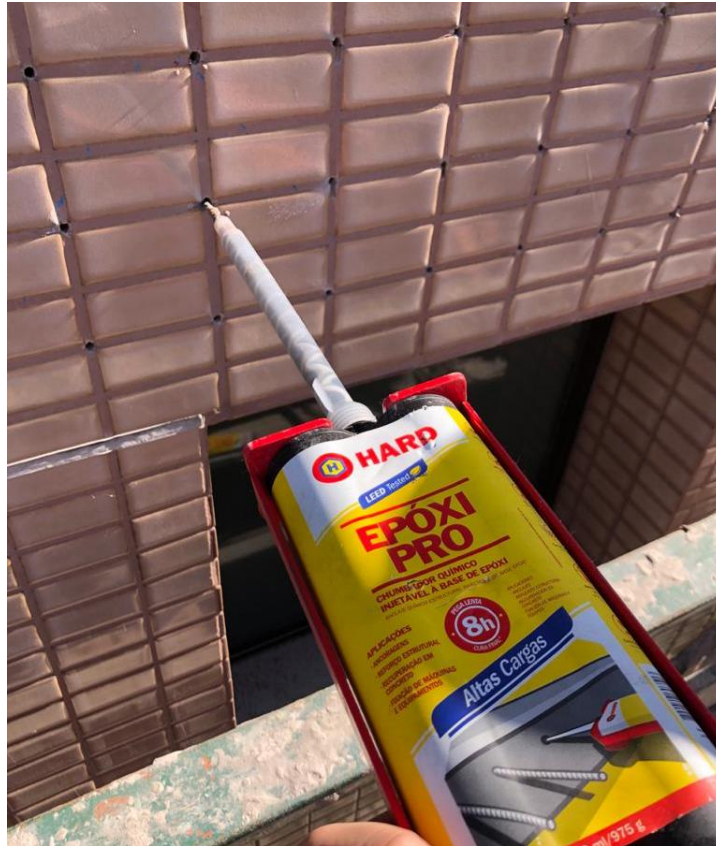
Figura 43 - Protótipo B - Injeção da resina epóxi
