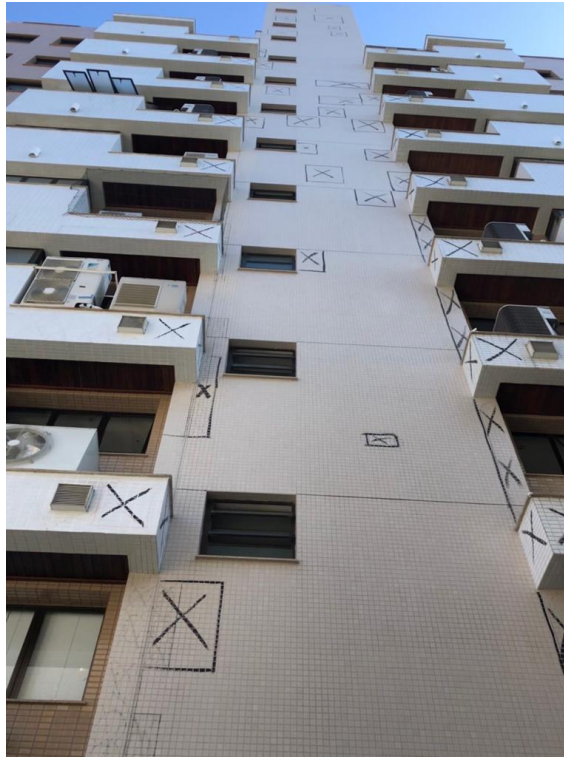
Figura 28 – Vista lateral do prédio
