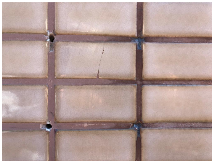
Figura 44 - Protótipo B - Injeção da resina epóxi
