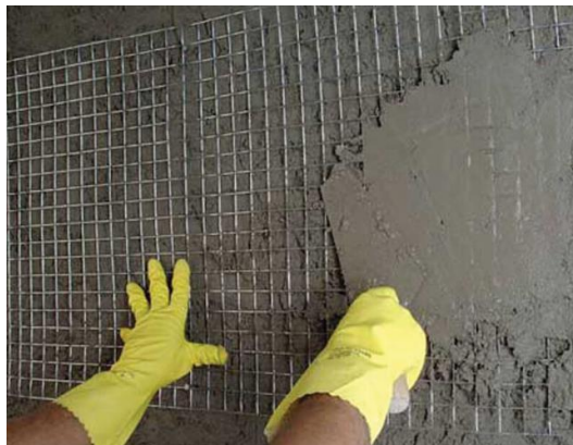
Figura 15 - Reforço do emboço com tela metálica
