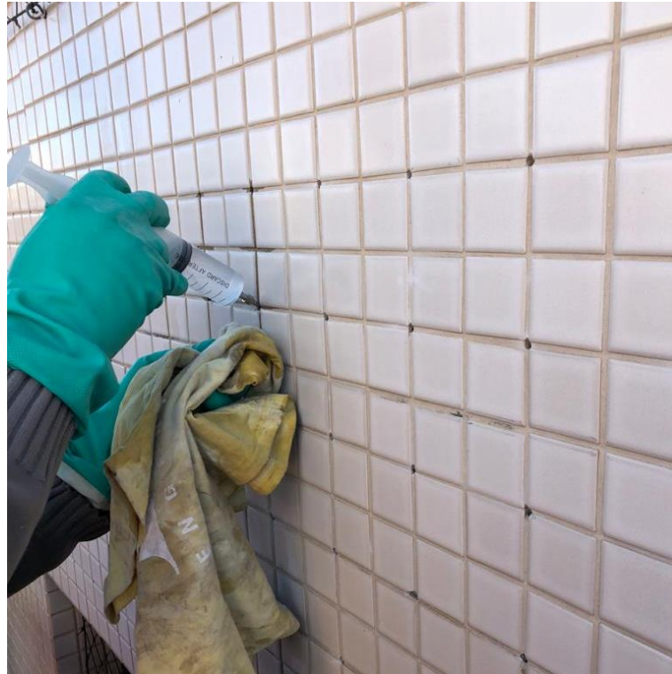
Figura 36 - Protótipos A e B - Injeção do Flúor Silicato
