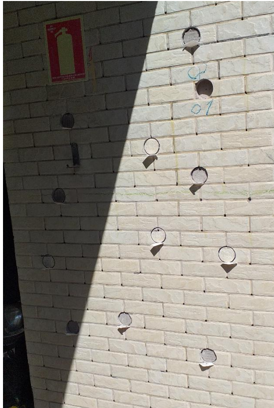
Figura 71 - Ensaio de arrancamento protótipo C
