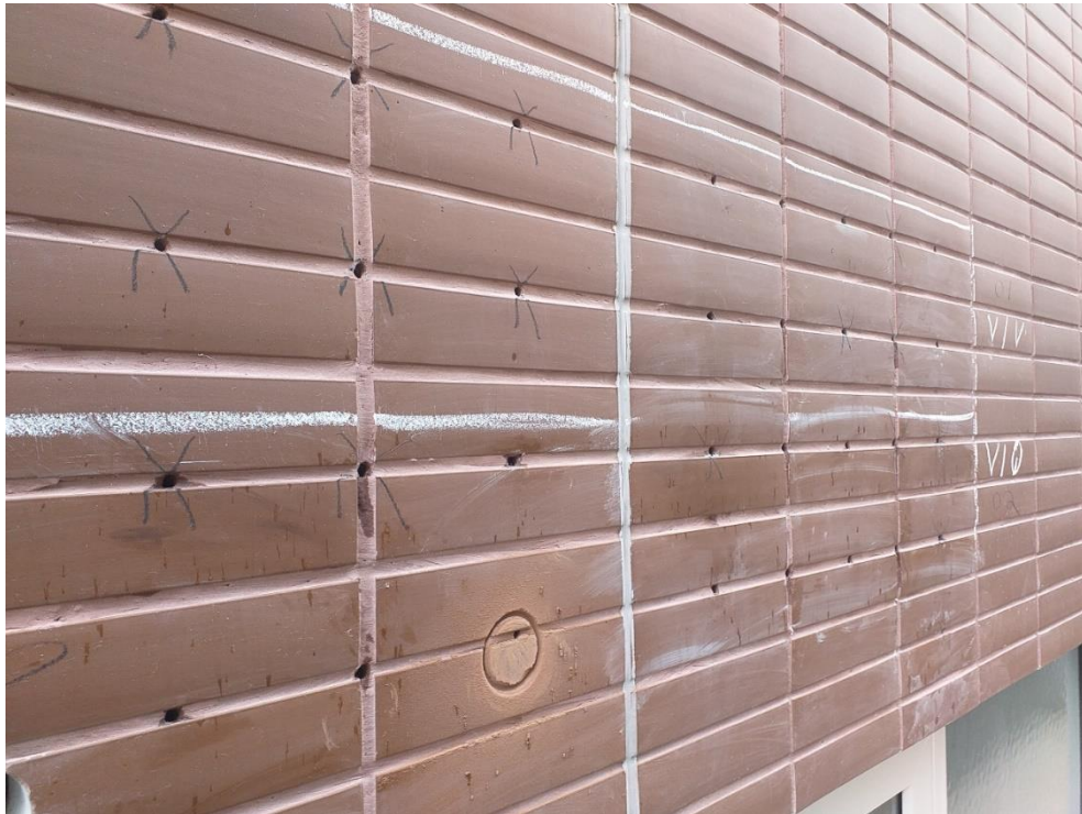
Figura 79 - Protótipos E e F - Pontos marcados com X onde o houve a permanência do som cavo após injeção da resina epóxi
