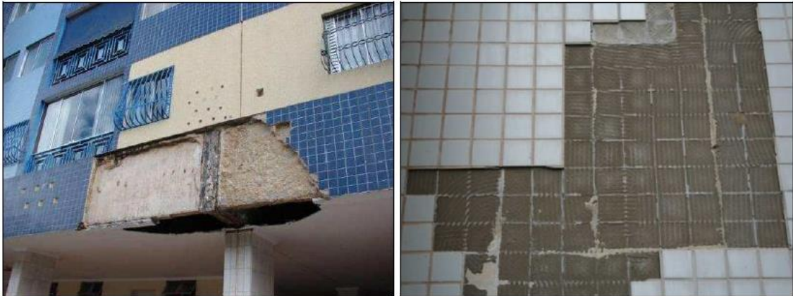
Figura 24 - Desplacamento cerâmico
