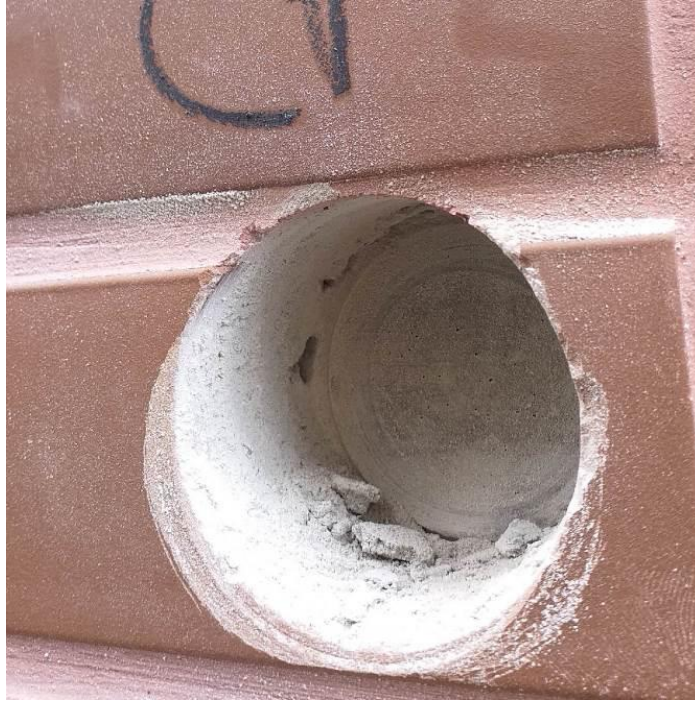
Figura 60 - Corpo de prova – Descolamento entre chapisco e base
