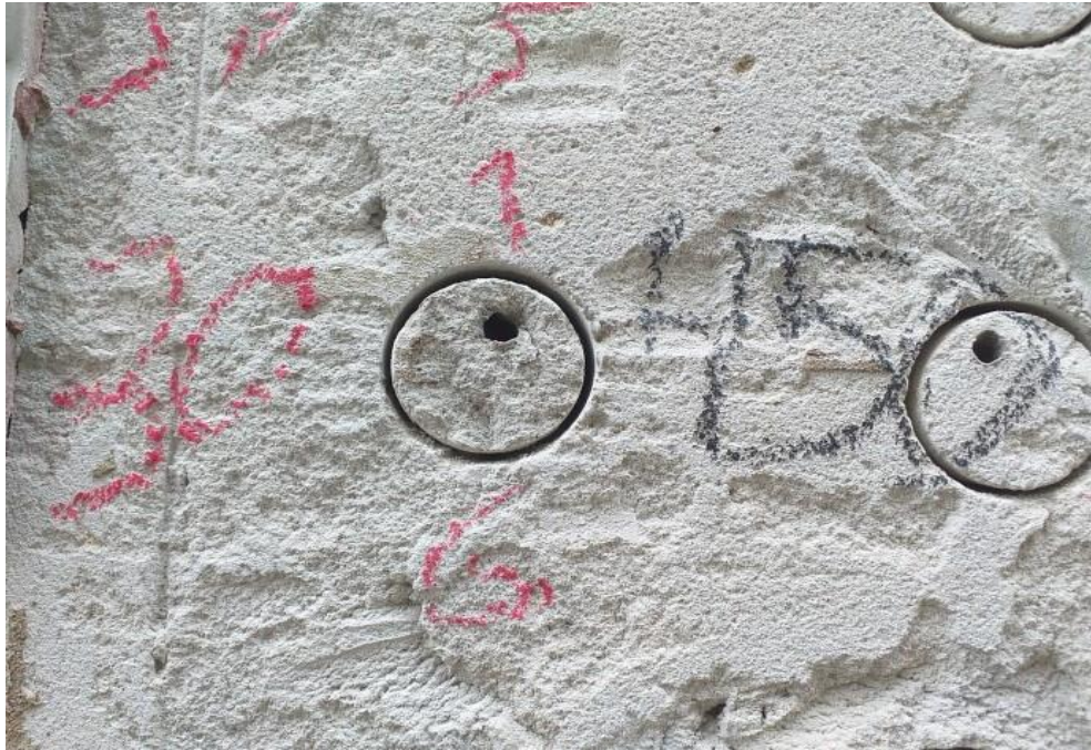
Figura 81 - Ensaio de arrancamento protótipo E – Ruptura na interface argamassa/cola
