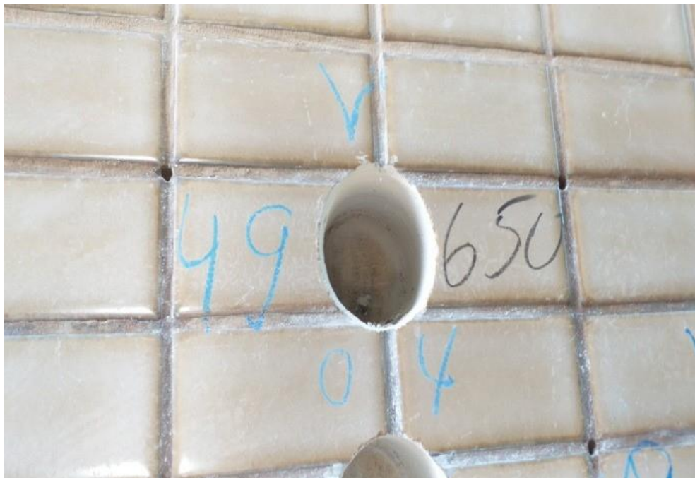
Figura 66 - Ensaio de arrancamento protótipo A – Ruptura na interface substrato/chapisco
