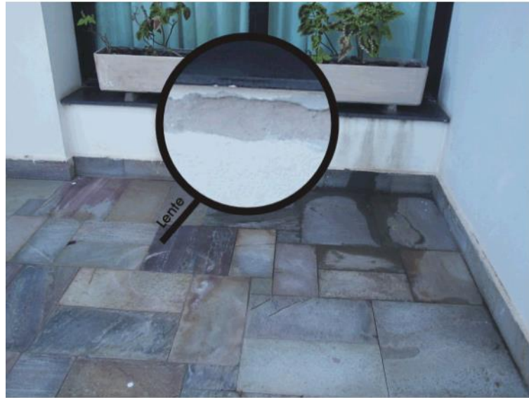
Figura 23 - Descolamento com pulverulência
