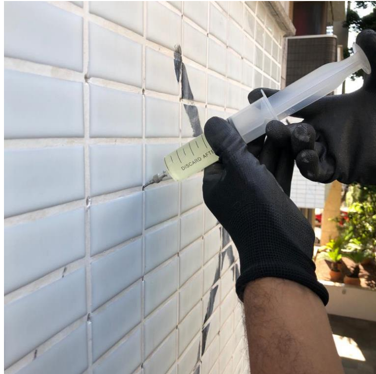
Figura 40 - Protótipo A - Injeção da resina epóxi
