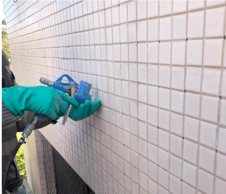
Figura 34 - Protótipos A e B - Limpeza dos furos com ar comprimido
