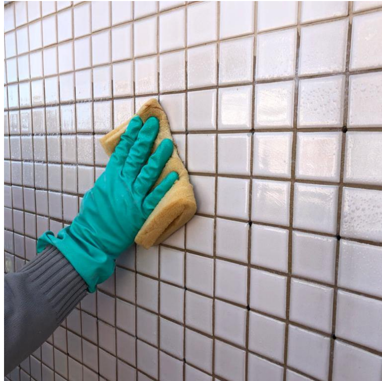
Figura 37 - Protótipos A e B - Limpeza da superfície
