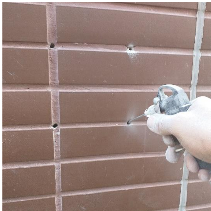
Figura 64 - Protótipos E e F - Limpeza dos furos com ar comprimido
