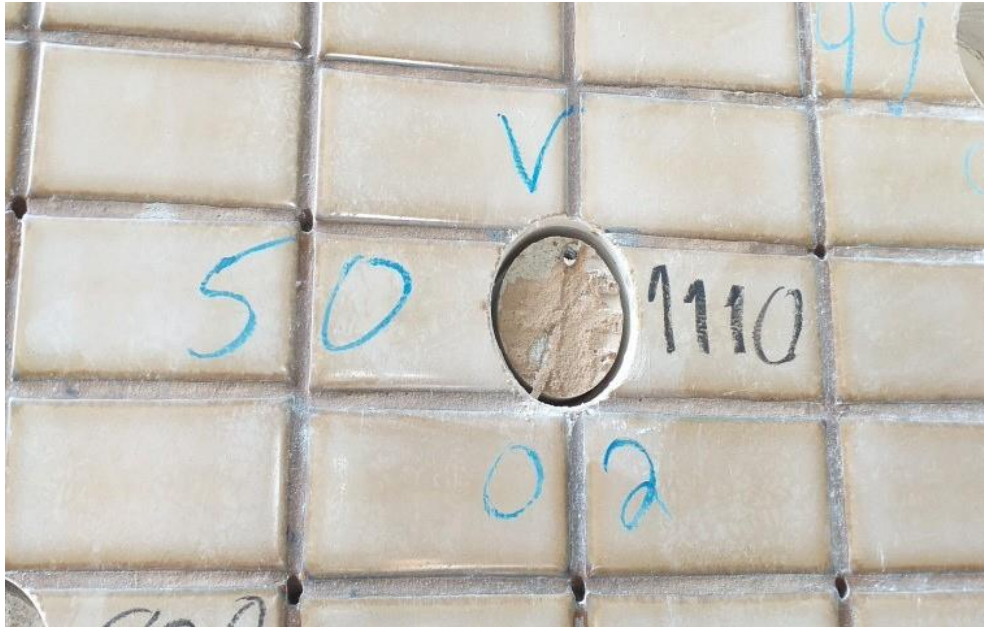
Figura 67 - Ensaio de arrancamento protótipo A – Ruptura na interface argamassa/cola
