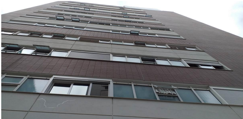
Figura 51 - Vista lateral esquerda do prédio
