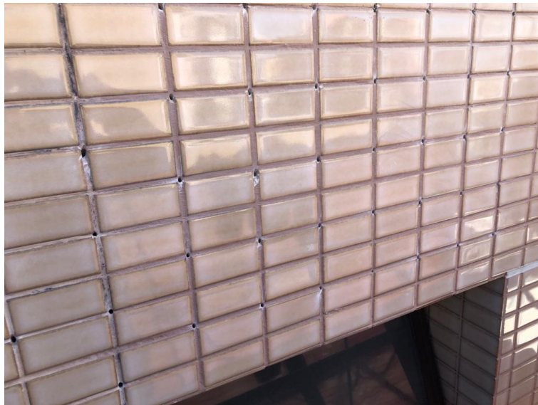
Figura 35 - Protótipos A e B - Furos 5mm de diâmetro para injeção do Flúor Silicato
