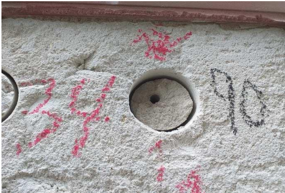
Figura 82 - Ensaio de arrancamento protótipo E – Ruptura no interior da argamassa
