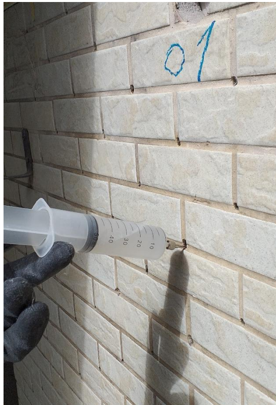
Figura 48 - Protótipos C e D - Injeção da resina epóxi
