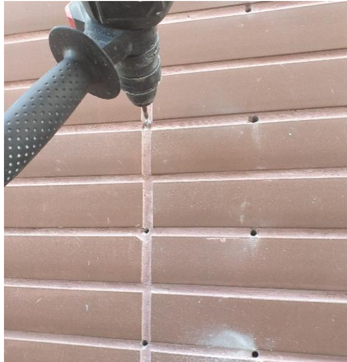
Figura 63 - Protótipos E e F - Furos com broca 6mm para injeção de resina
