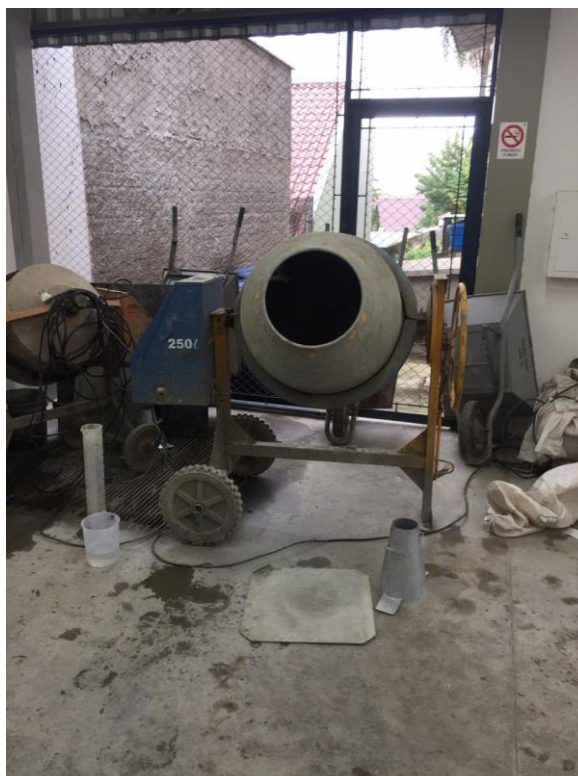
Figura 29: Preparação do concreto.
