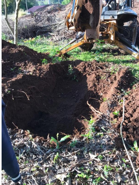
Figura 16 - Abertura da trincheira 2
