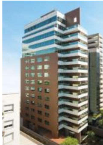
Figura 8 - Edifício Bela Cintra, São Paulo
