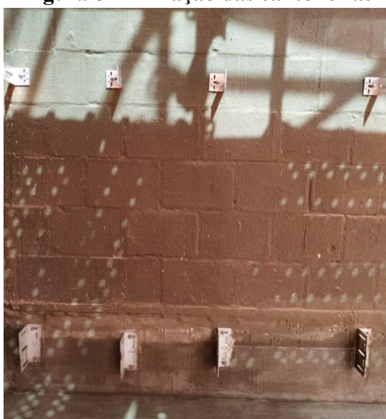
Figura 81 – Fixação das cantoneiras
