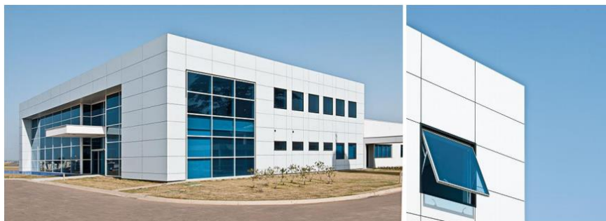
Figura 33 - Fachada ventilada com revestimento Laminum (porcelanato técnico)
