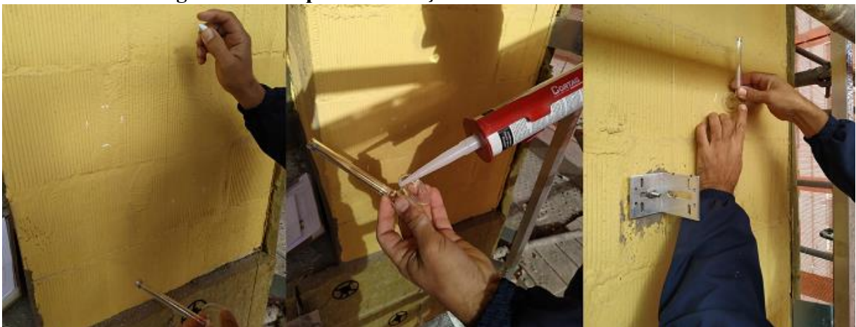
Figura 51 – Etapas de execução do Método do Cachimbo
