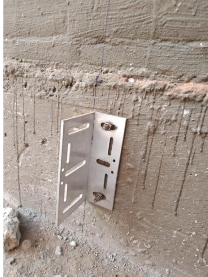
Figura 73 – Fixação pontual de chumbador mecânico em elemento de concreto armado
