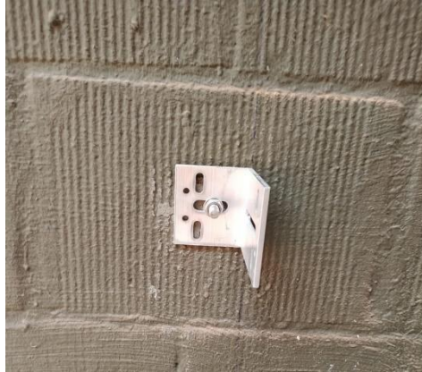
Figura 67 – Fixação pontual testada nos blocos cerâmicos estruturais de 18MPa
