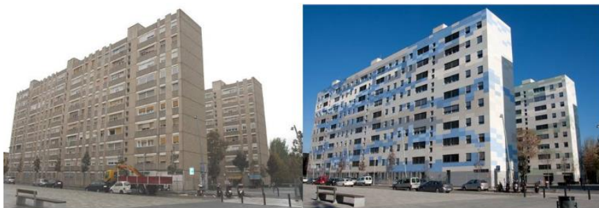
Figura 12 – Reabilitação do Edifício Fonsanta, Barcelona
