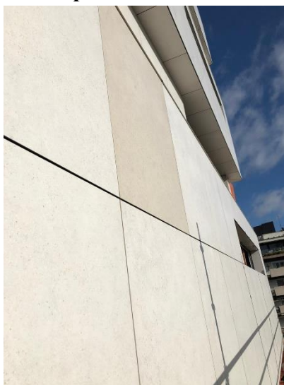
Figura 95 – Placa de porcelanato com coloração diferente
