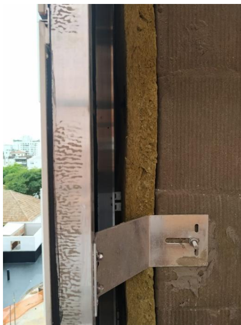
Figura 94 – Elementos da fachada ventilada
