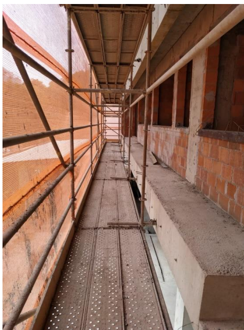
Figura 75 – Andaime fachadeiro utilizado na obra
