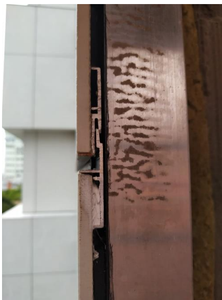
Figura 93 – Espaçador das placas de porcelanato
