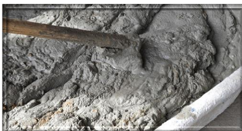
Figura 10 – Fazendo massa de cimento com enxada na caixa
