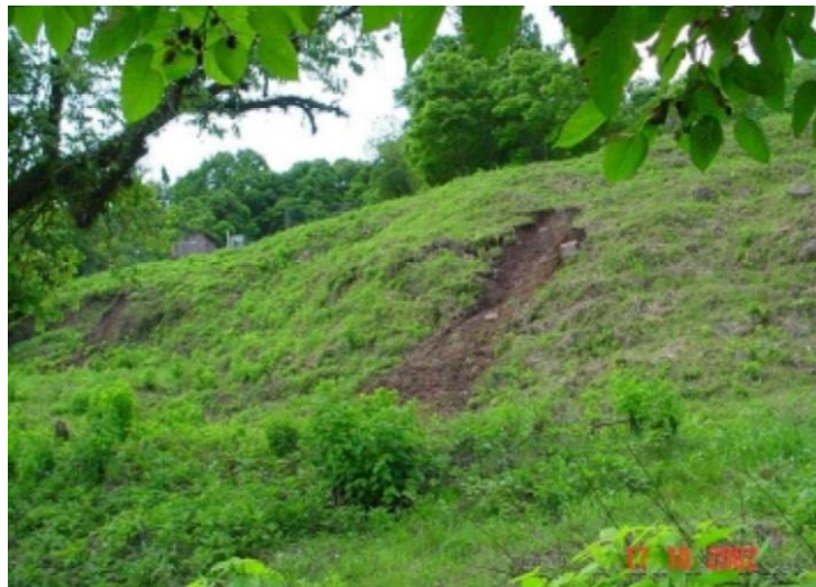
Figura 9 - Deslizamento do Tipo Corrida no Bairro Santo Inácio - SCS
