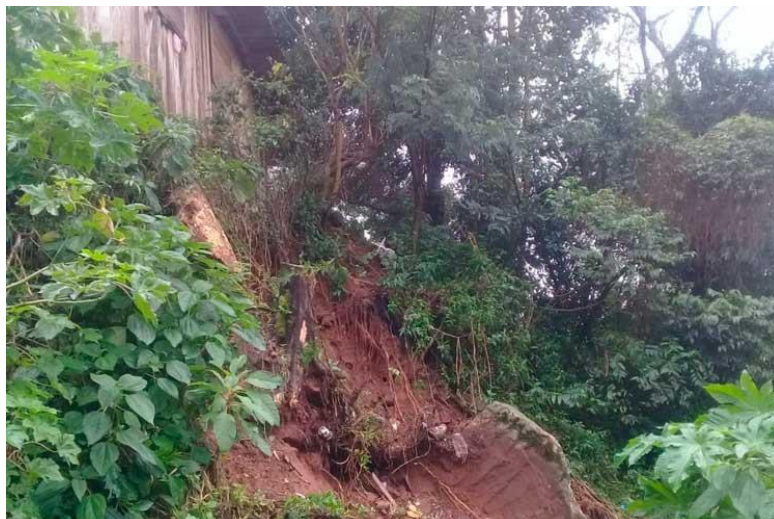
Figura 13 - Deslizamento de Encosta no Bairro Margarida - SCS
