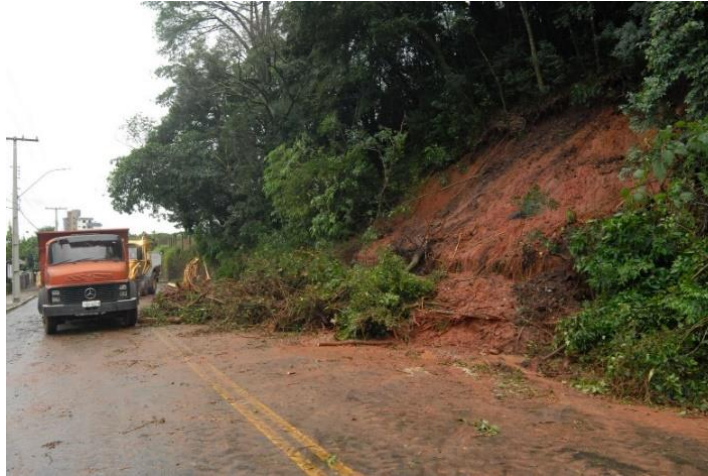
Figura 10 - Deslizamento no Bairro Belvedere - SCS
