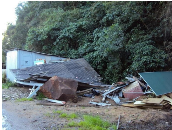
Figura 11 - Queda de Bloco no Bairro Belvedere - SCS
