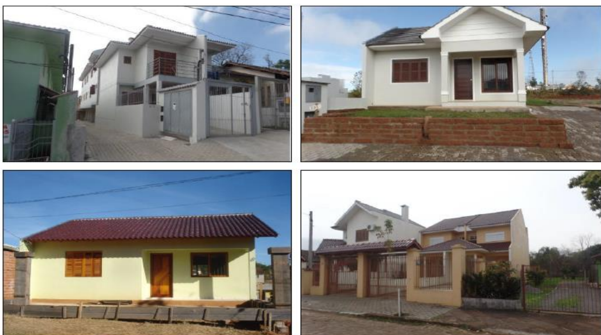
Figura 2 – Casas alvenaria padrão médio. Fonte: Manual tipologias PMSCS
