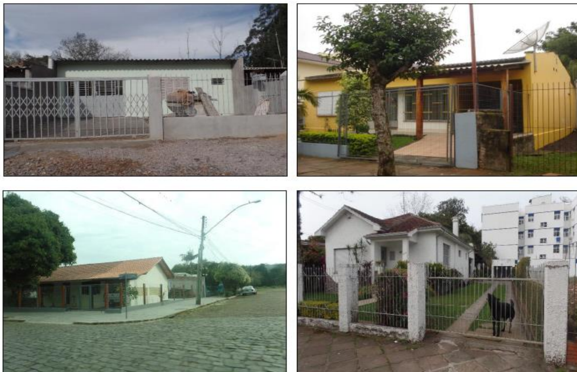
Figura 1 – Casas alvenaria padrão simples. Fonte: Manual tipologias PMSCS
