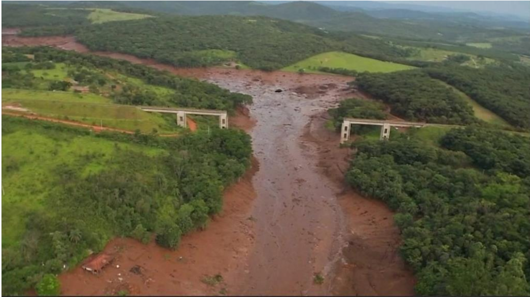
Figura 3 – Rompimento de barragem em Brumadinho/MG.
