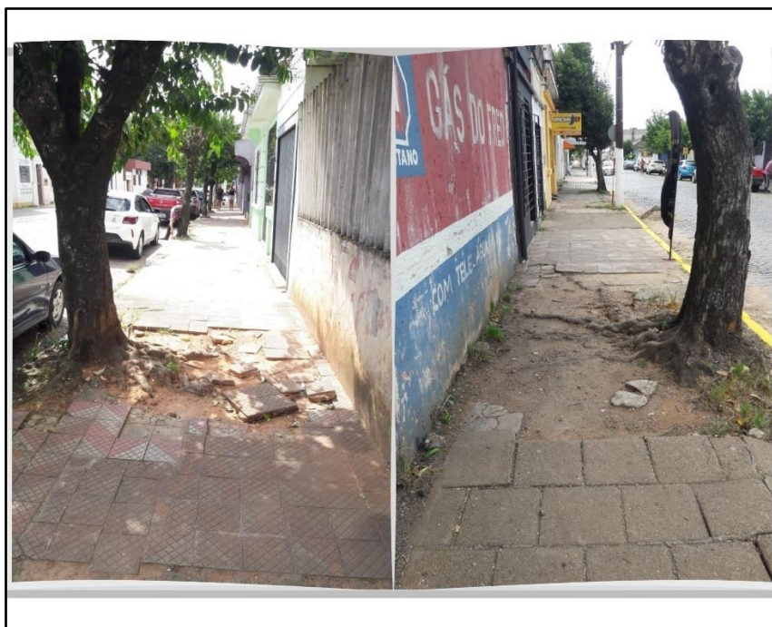
Figura 14 – Trechos não pavimentados dos segmentos Sp3 e Sp4
