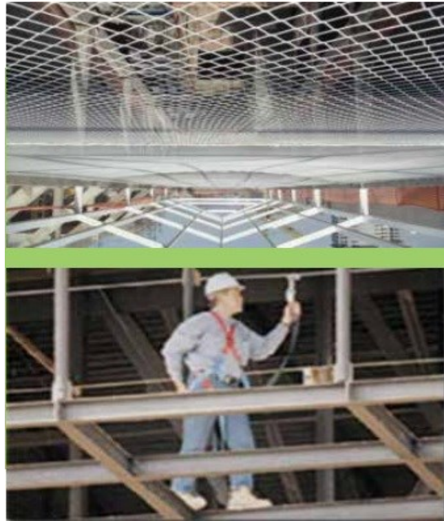
Figura 2 – Proteção Contra Queda em Altura
