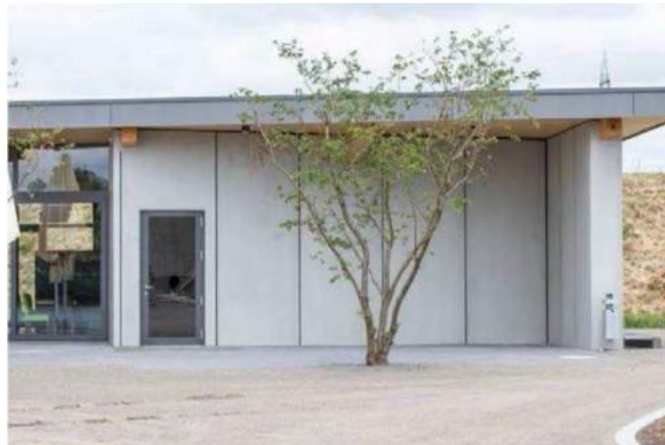
Figura 15 – Fachada-cortina ventilada SchieferErlebnis, Dormettingen
