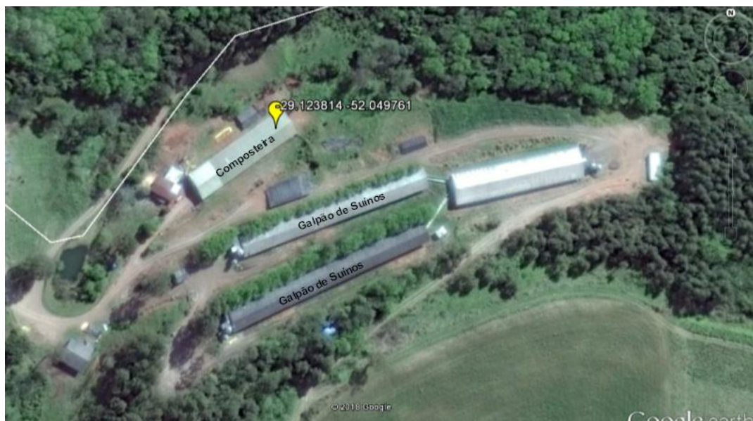
Figura 10: Vista geral das instalações do sistema de criação e do sistema de compostagem dos dejetos (Fonte: Google Earth).
