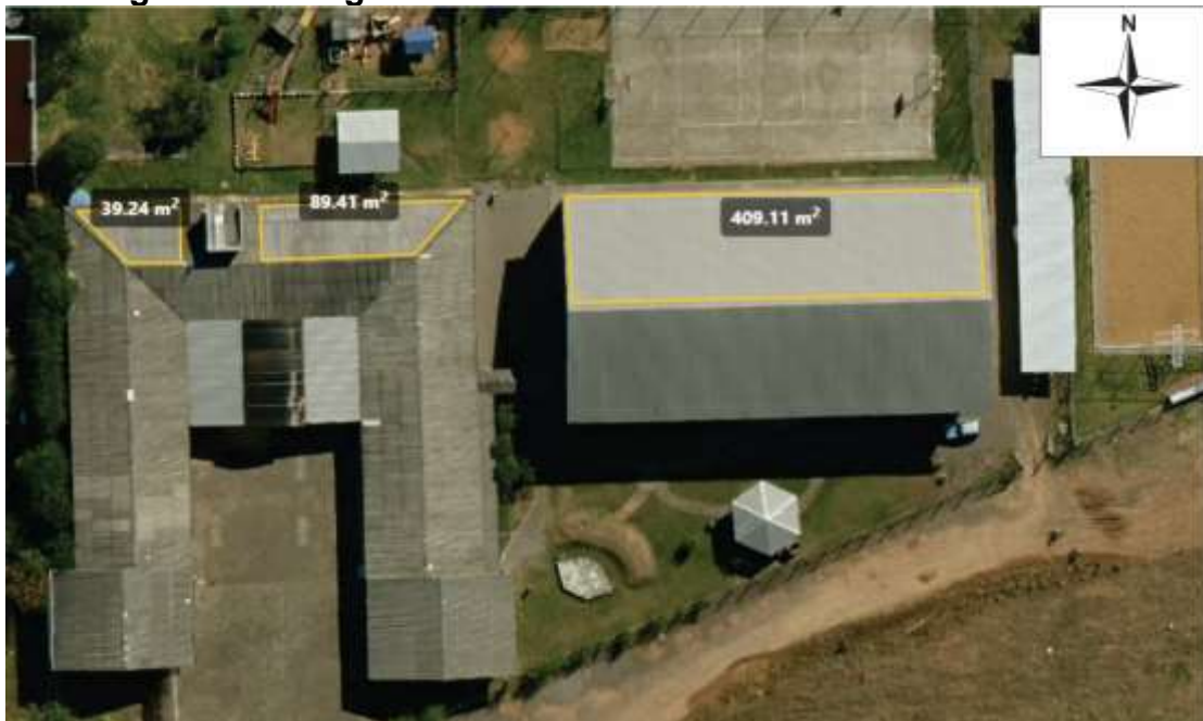
Figura 69 - Imagem do telhado EMEF Leonel de Moura Brizola
