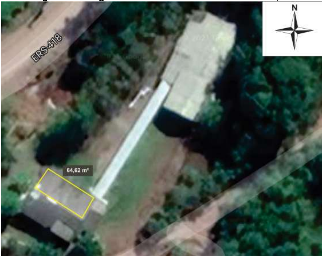
Figura 67 - Imagem do telhado EMEF Imaculada Conceição
