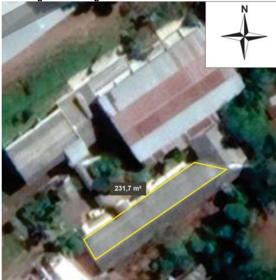
Figura 41 - Imagem do telhado EMEF Cardeal Leme
