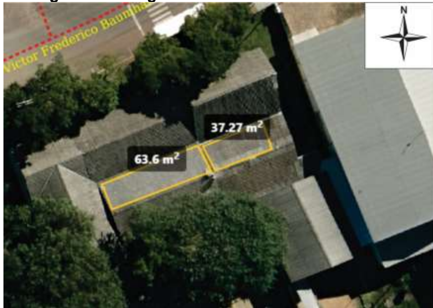
Figura 81 - Imagem do telhado EMEF São Canísio
