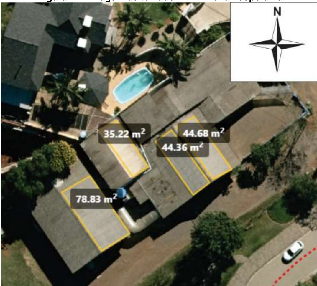
Figura 47 - Imagem do telhado EMEF Dona Leopoldina
