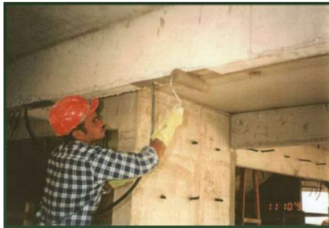
Figura 2 – Chapisco rolado para aumento da ligação alvenaria/estrutura
