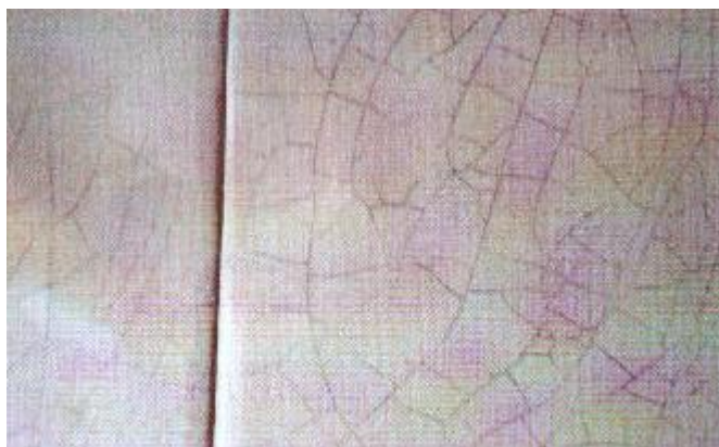
Figura 11 - Gretamento de placas cerâmicas
