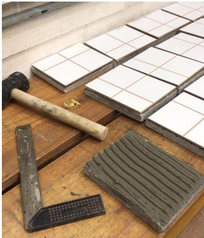
Figura 23 - Colagem das placas cerâmicas com argamassa colante AC III
