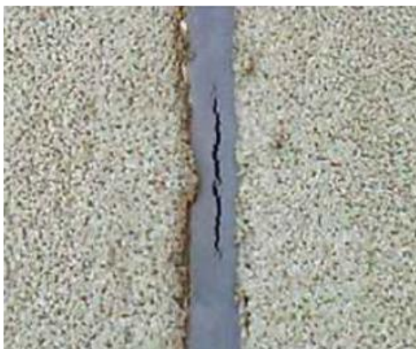
Figura 16 - Ruptura coesiva de selante
