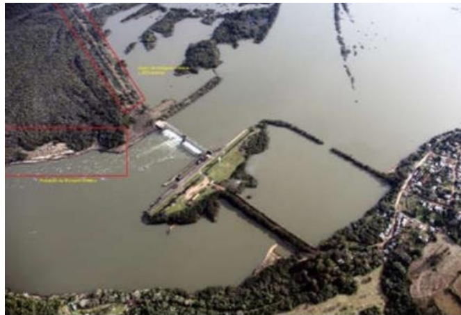
Figura 42: Dique e Proteção Margem Direita
