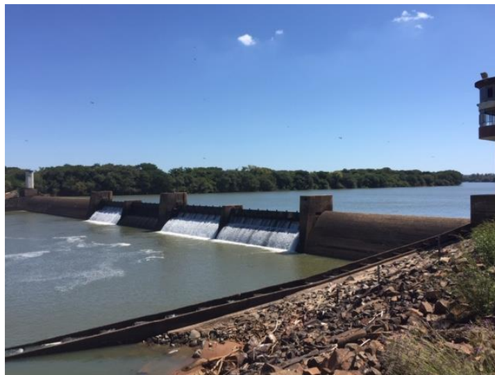
Figura 38: Vista das comportas fechadas
