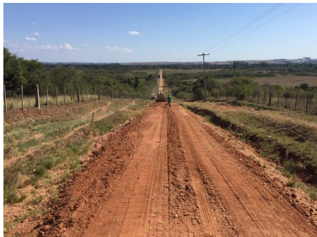
Figura 36: Estrada de acesso à barragem
