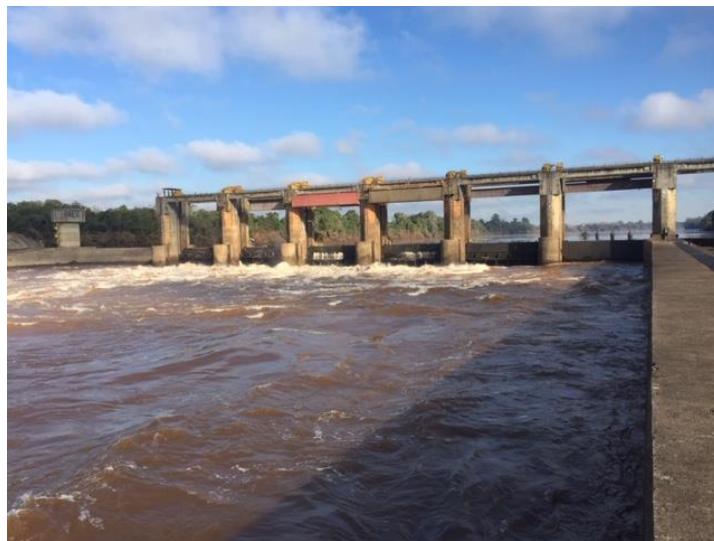
Figura 24: Barragem à jusante
