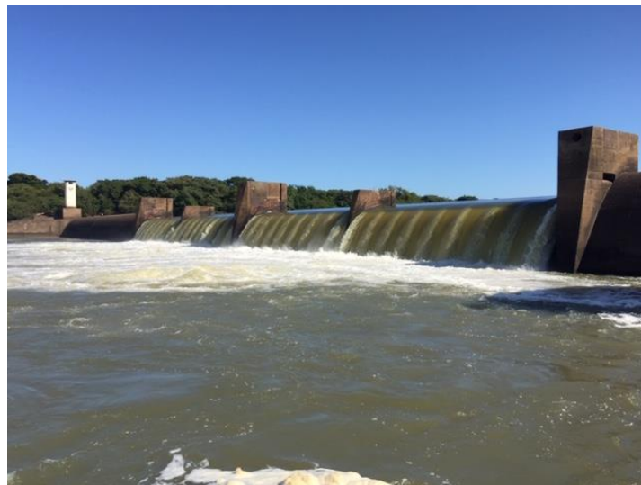
Figura 39: Vista das comportas abertas
