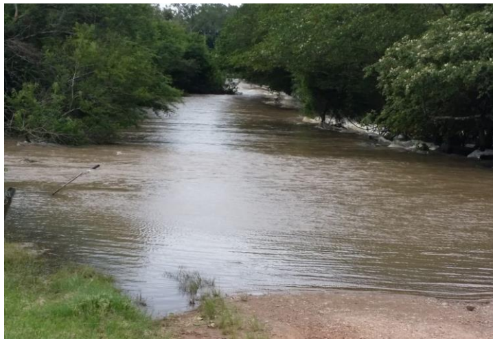
Figura 41: Dique da margem esquerda (época de enchente)
