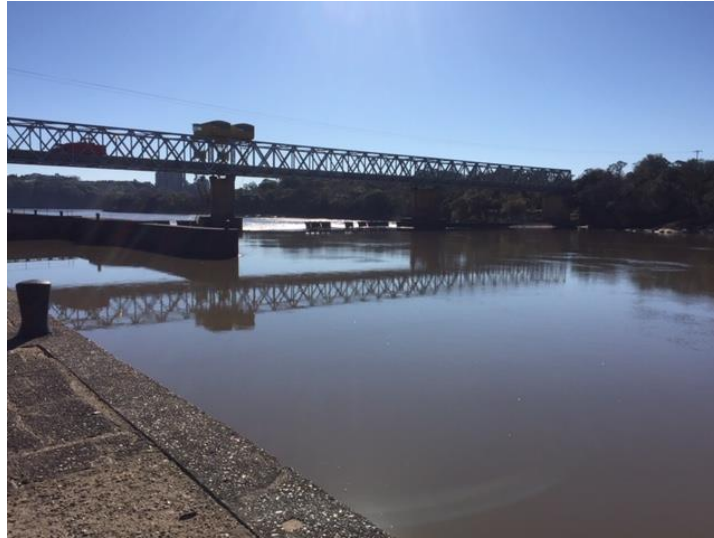
Figura 3: Barragem / Eclusa (vista montante para jusante)
