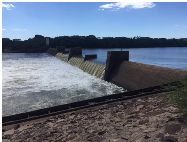
Figura 9: Barragem do Anel de Dom Marco (vista jusante para montante)
