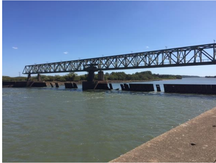
Figura 16: Barragem (vista de jusante para montante)
