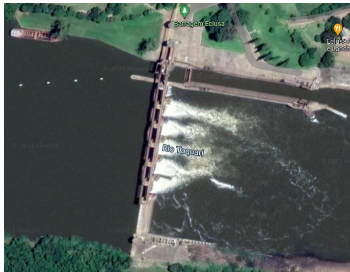
Figura 22: Imagem de satélite da barragem
