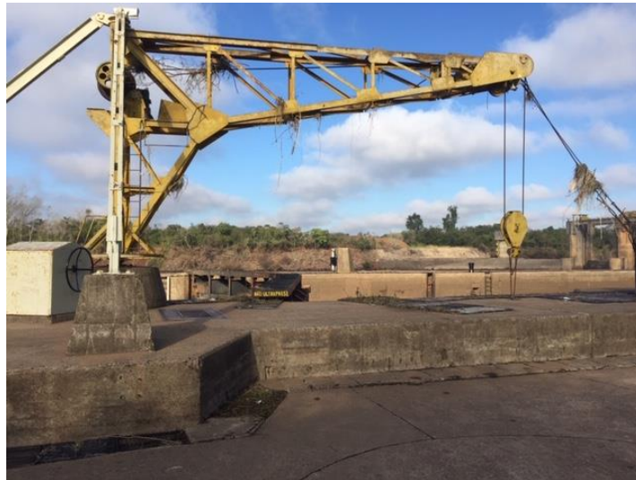
Figura 27: Derrick da eclusa
