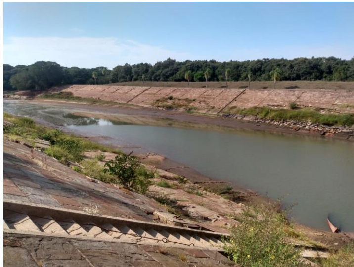
Figura 33: Canal de acesso a eclusa por jusante
