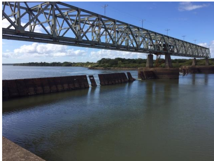
Figura 17: Barragem (vista de montante para jusante)
