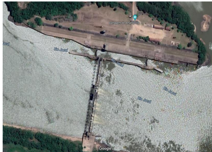
Figura 15: Imagem de satélite da barragem
