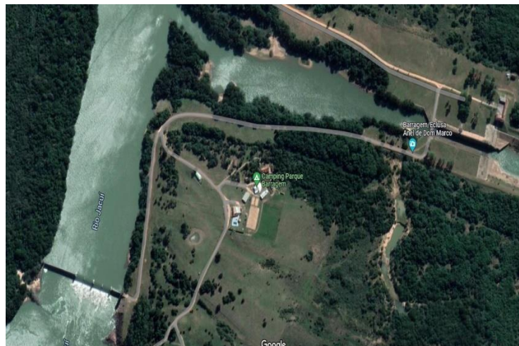
Figura 8: Imagem de satélite da barragem
