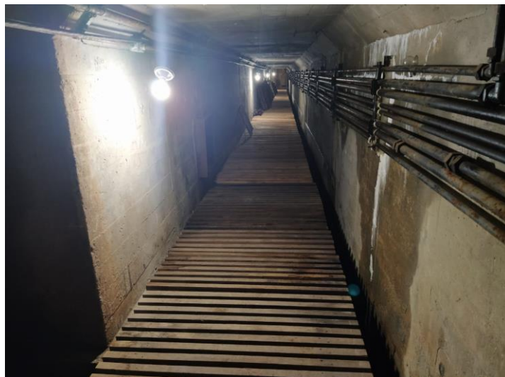
Figura 37: Túnel da barragem
