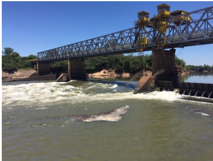
Figura 4: Barragem / Eclusa (vista jusante para montante)
