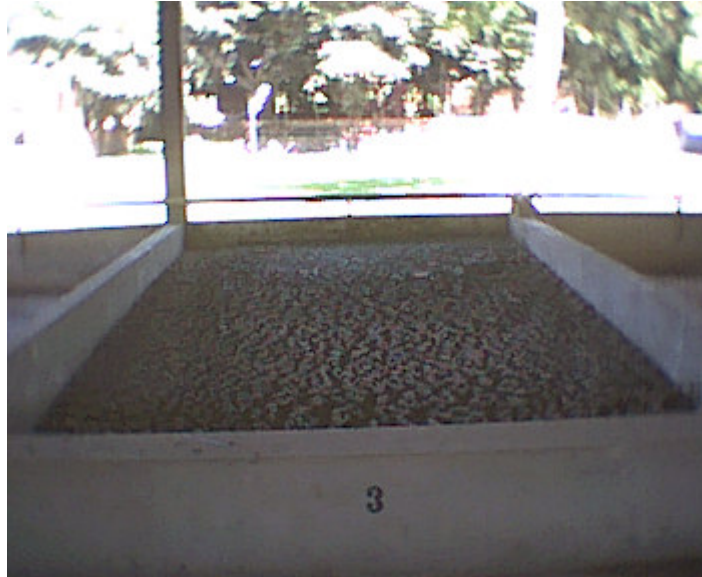
Vista do lodo biológico acondicionado nos leitos de secagem.
