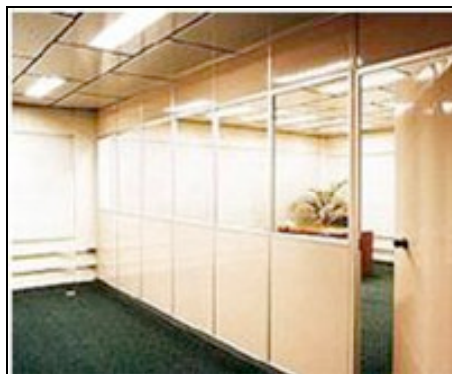
Figura 2. Exemplo de Paredes de divisórias.
