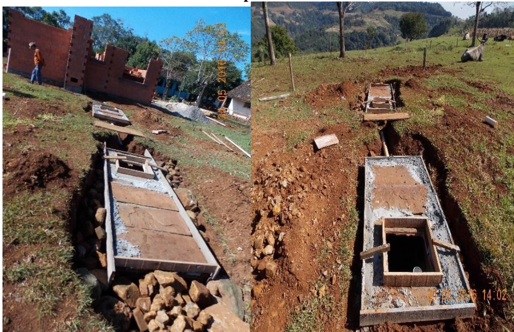
Foto 6 – Obras das fossas sépticas nas unidades habitacionais.
