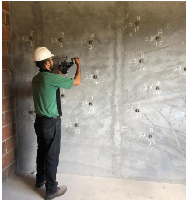
Figura 43 – Realização do arrancamento das pastilhas metálicas
