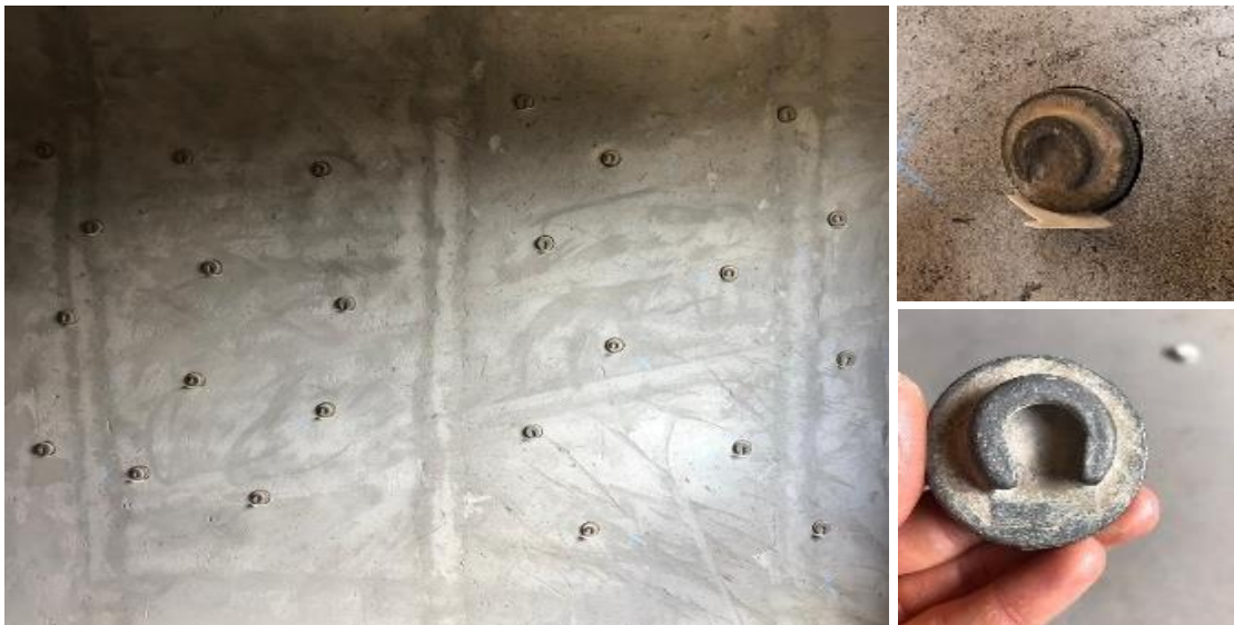
Figura 42 – Colagem das pastilhas metálicas
