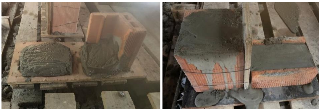
Figura 31 – Graute aplicado nos blocos cerâmicos
