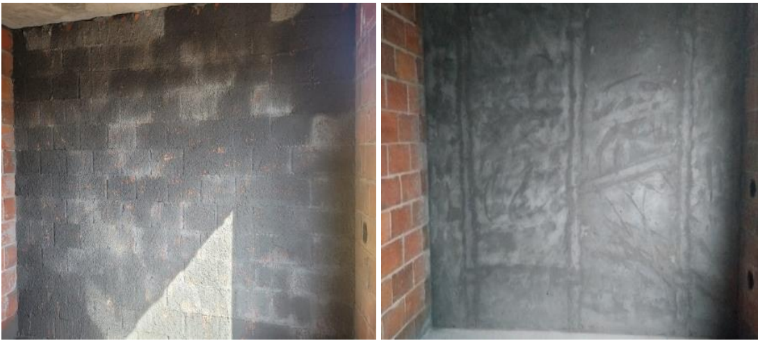
Figura 40 – Parede com chapisco e reboco
