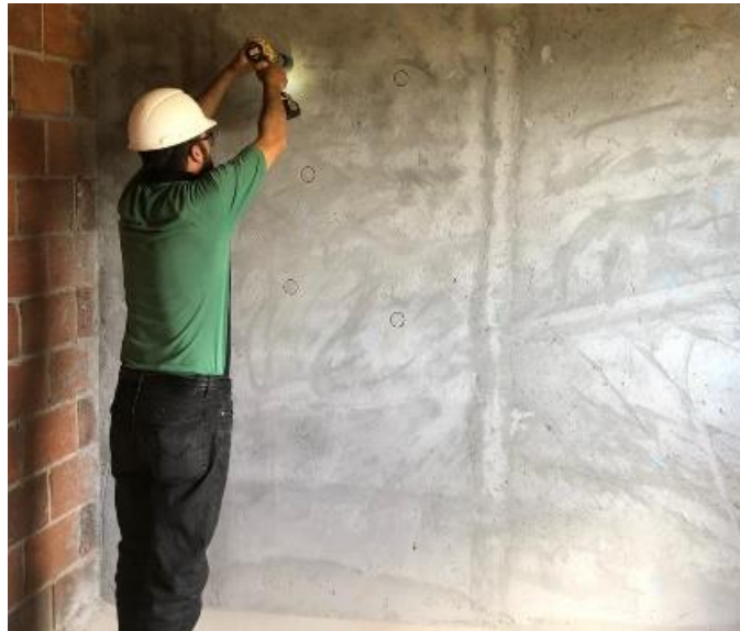
Figura 41 – Realização dos furos no revestimento
