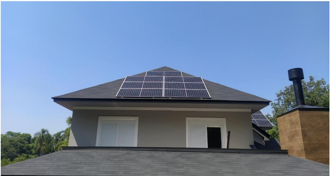
Imagem 12: Disposição dos módulos em telha single.
