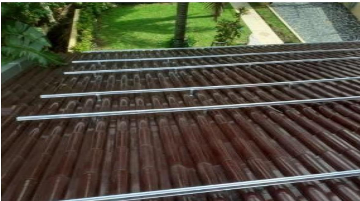
Imagem 8: Estrutura de fixação em telha esmaltada
