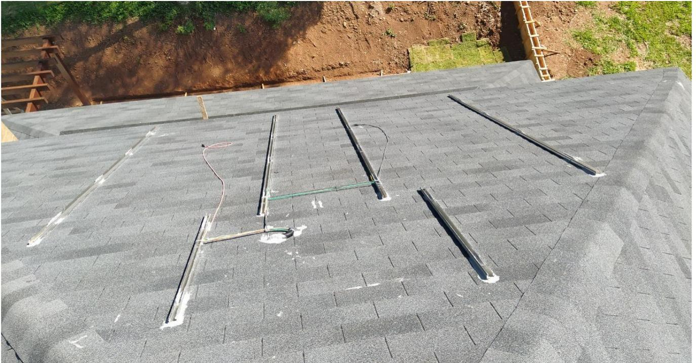
Imagem 11: Estrutura de fixação em telha single.
