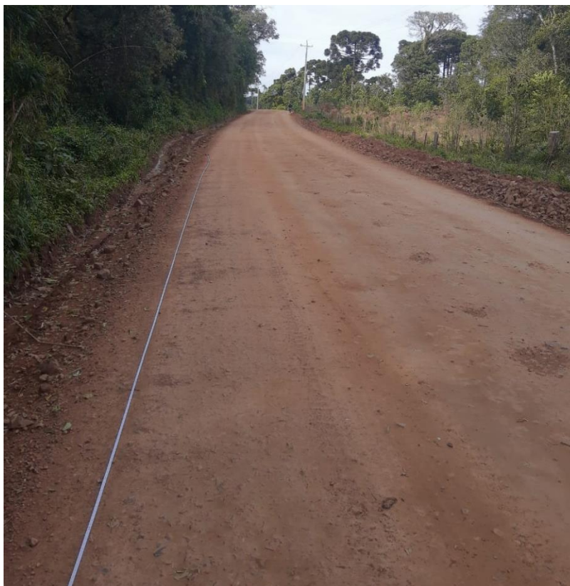
Figura 27 – Falta e deficiência de valetas na estrada
