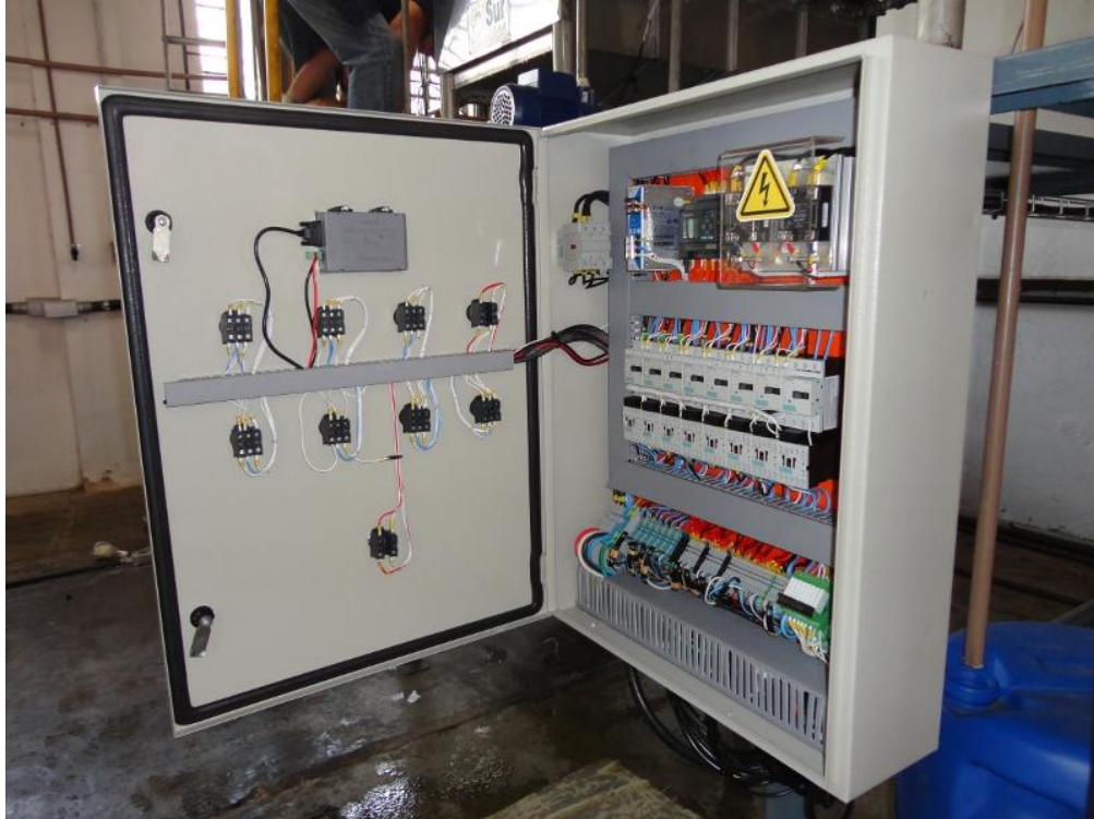
Figura 39 – Instalação do quadro de comando em junho de 2011.
