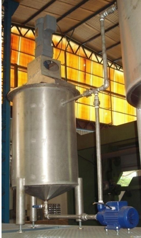
Figura 27 – Imagem do tanque de purificação do biodiesel por adsorção.
