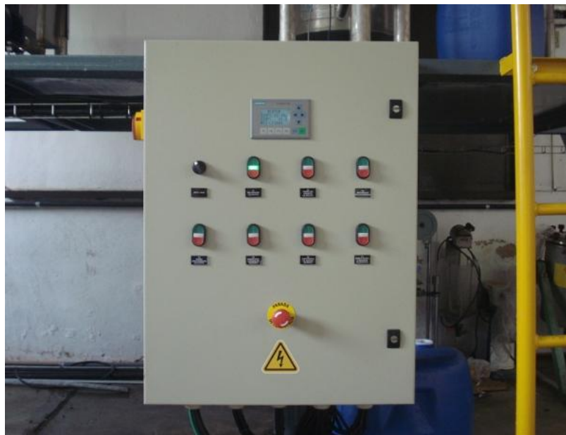
Figura 42 – Interface de operação do quadro de comando.
