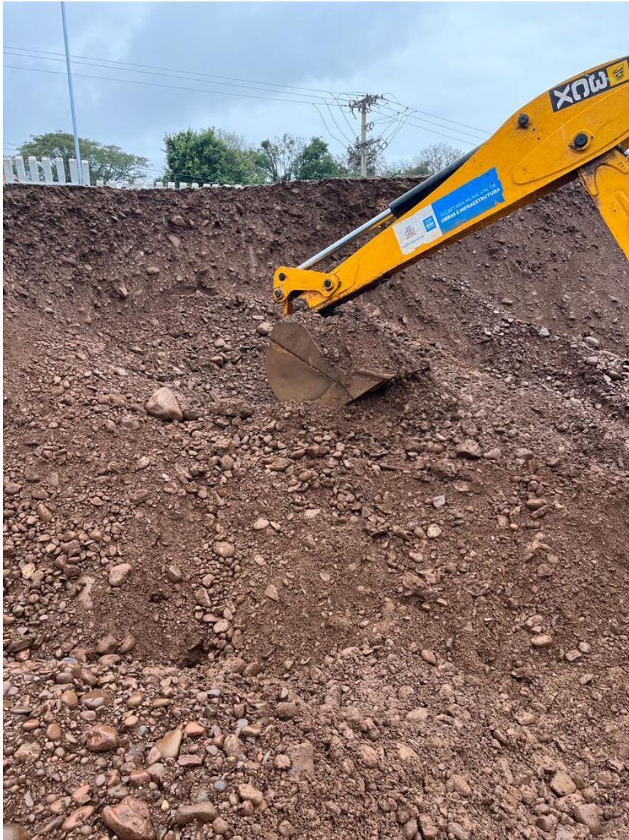
Figura 20 - Extração do material na Secretaria de Obras de Santa Cruz do Sul.
