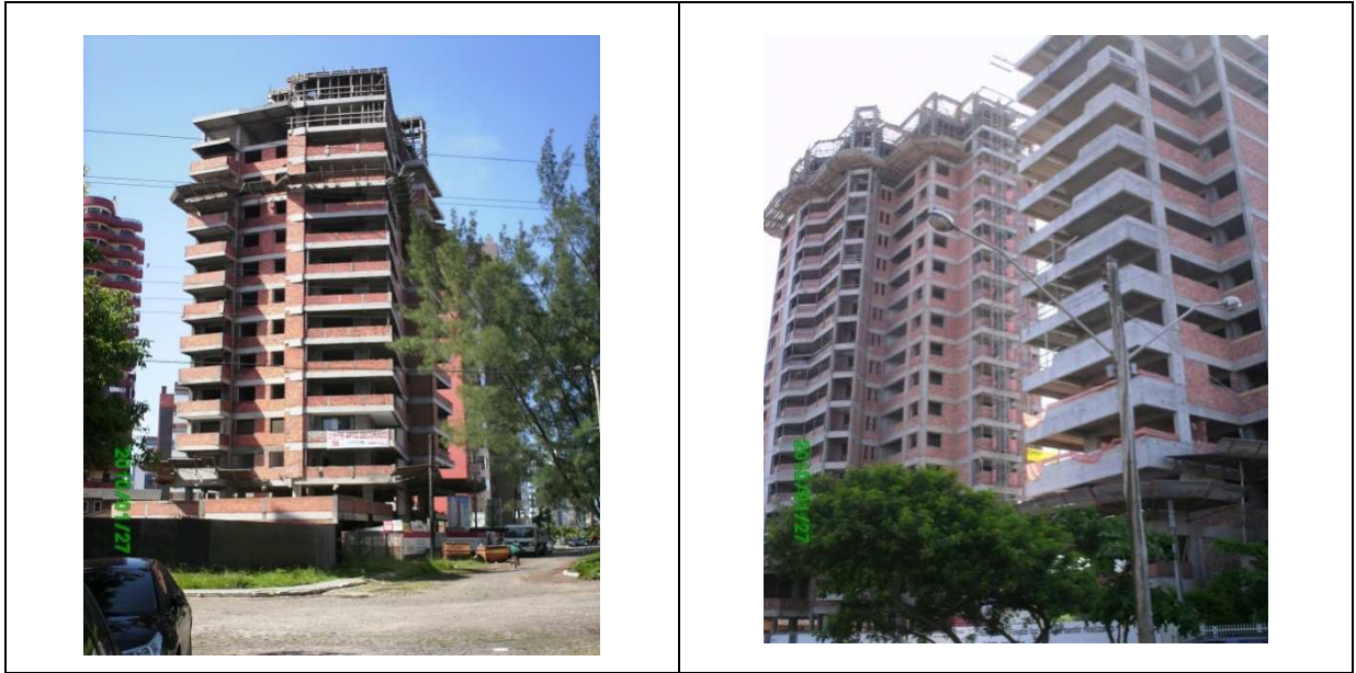
FIGURA 17 – Alguns edifícios em construção na sede do município de Torres-RS.
