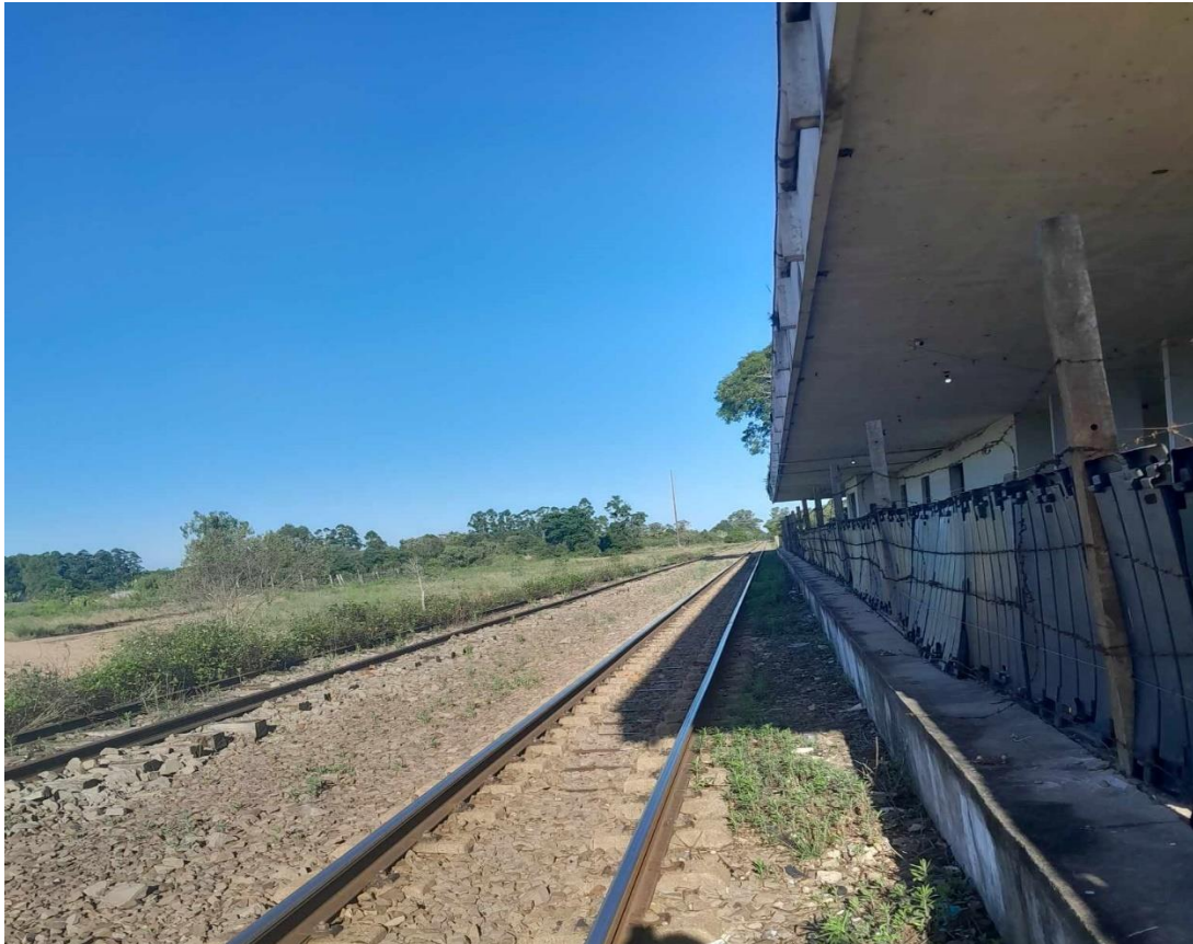
Figura 20 – Terminal Ferroviário da Volta da Charqueada em Cachoeira do Sul, próximo ao Porto
