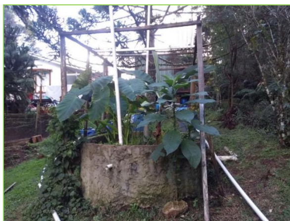
Figura 8. Sistema sanitário (TEVAP) utilizado na residência entre 2017 e 2022.
