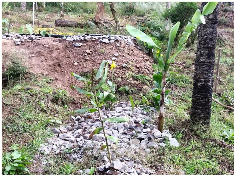
Figura 15. Vala de infiltração final.
