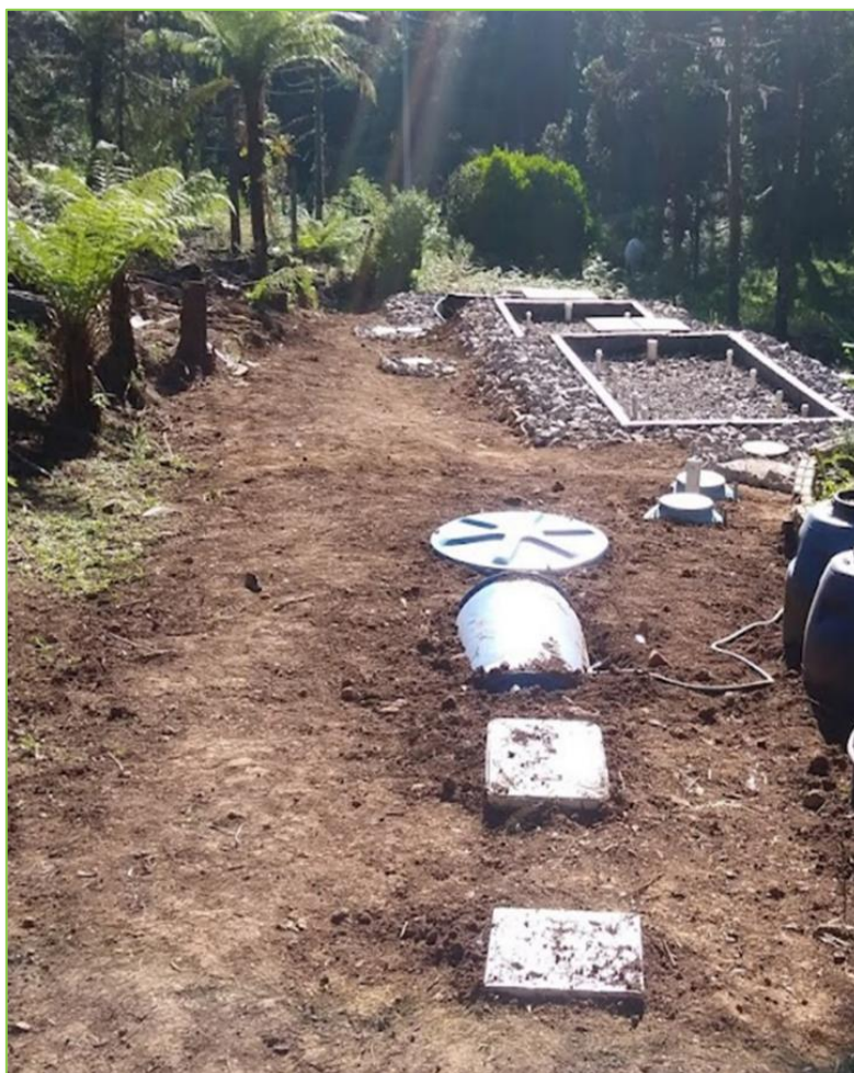
Figura 11. Indicação das caixas de gordura e gradeamento.
