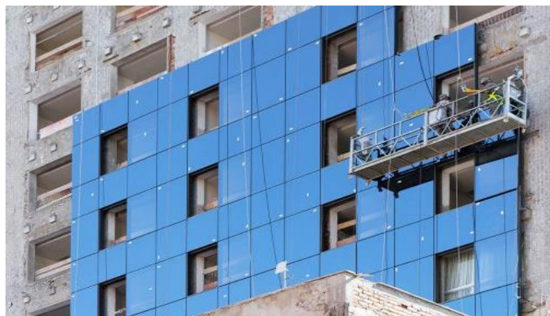
Figura 18 – Fachada ventilada revestida em vidro
