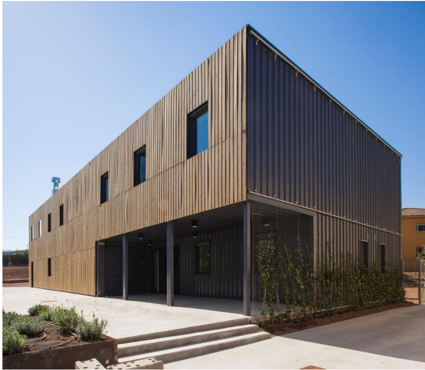
Figura 15 – Fachada ventilada em madeira
