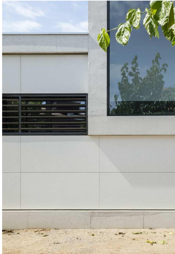
Figura 14 – Fachada ventilada em concreto polímero
