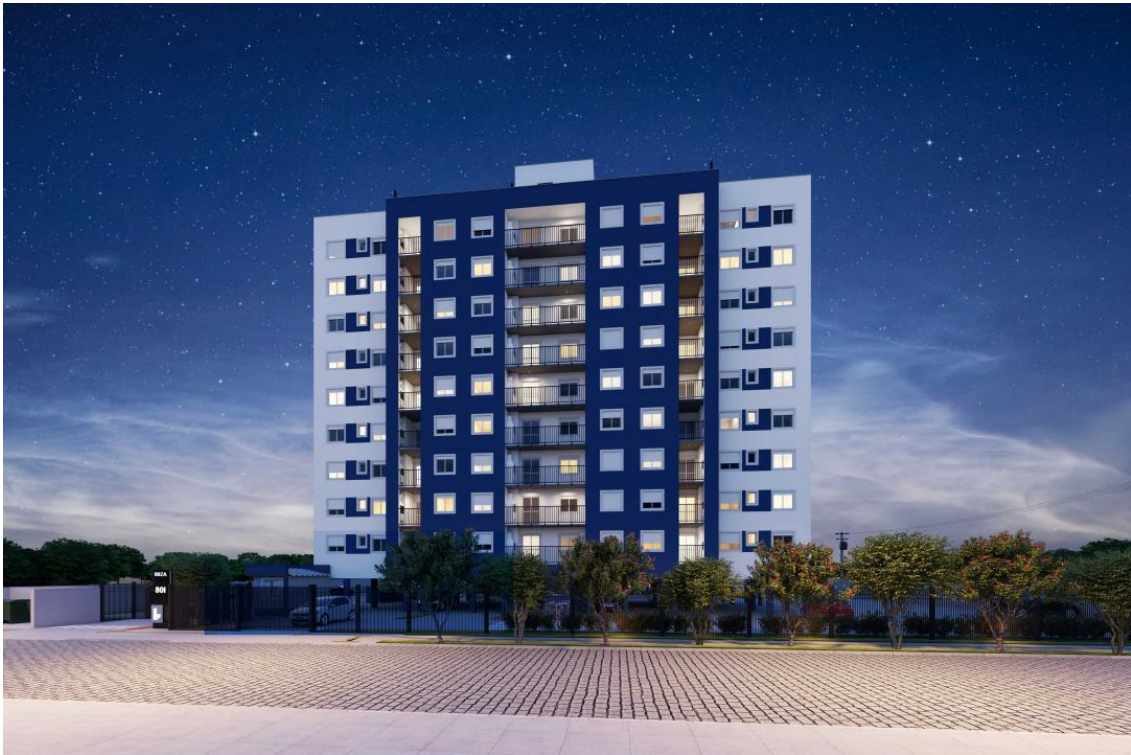
Figura 23 - Fachada do empreendimento Residencial Ibiza
