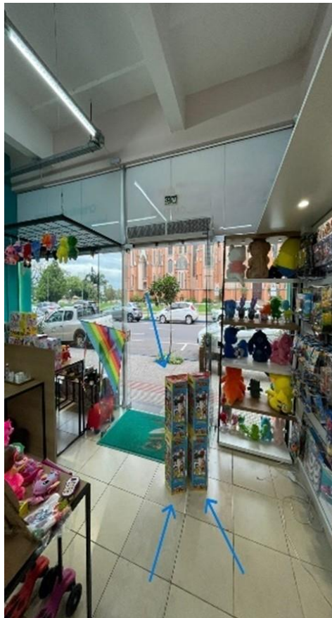
Figura 25 - Obstrução da saída de emergência
