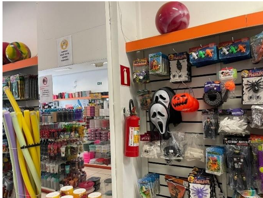
Figura 13 – Extintor de incêndio obstruído
