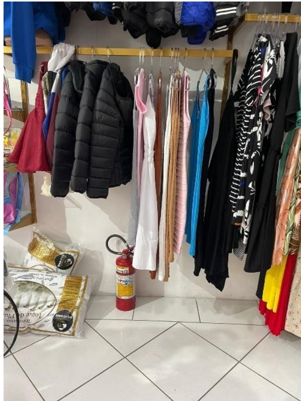
Figura 16 - Extintor de incêndio obstruído e sem sinalização
