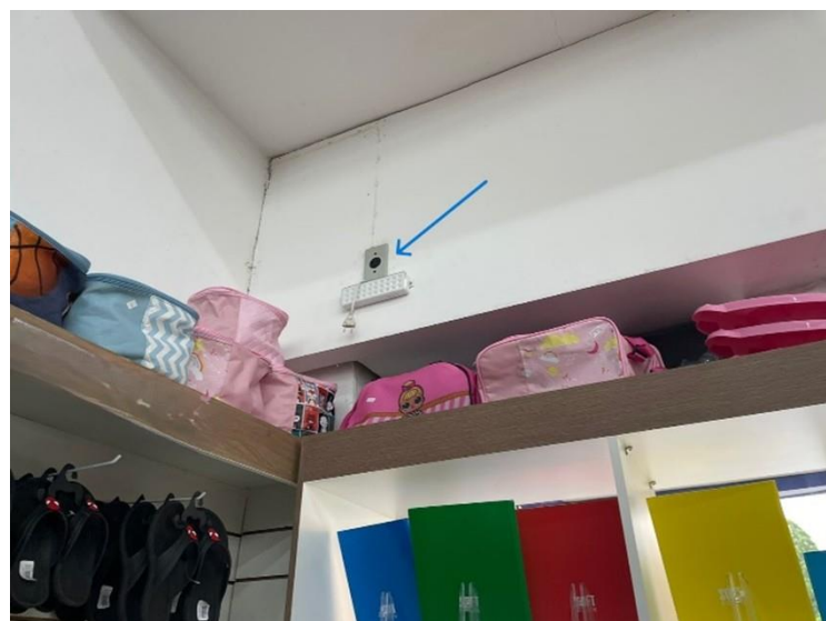
Figura 24 - Iluminação de emergência desligada
