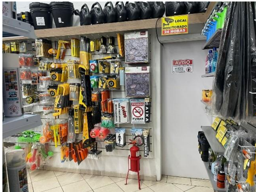
Figura 14 - Extintor de incêndio sem sinalização
