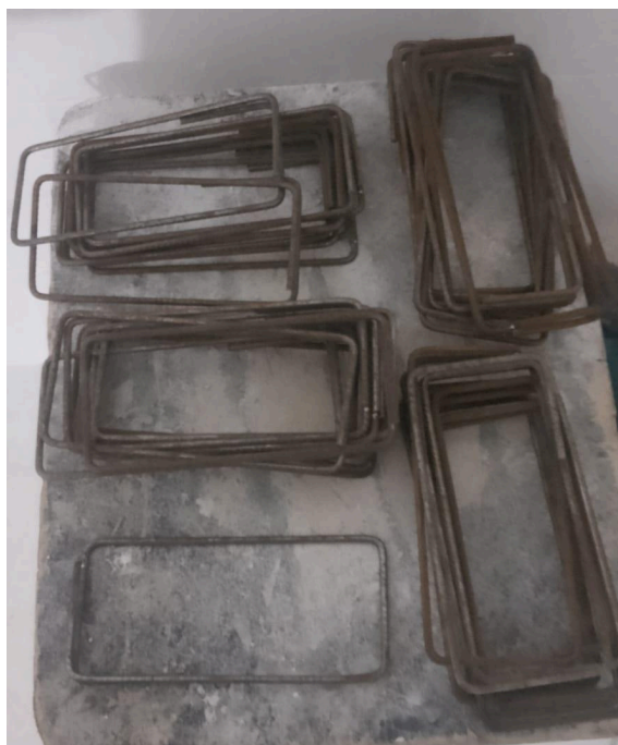
Figura 21 - Estribos dobrados
