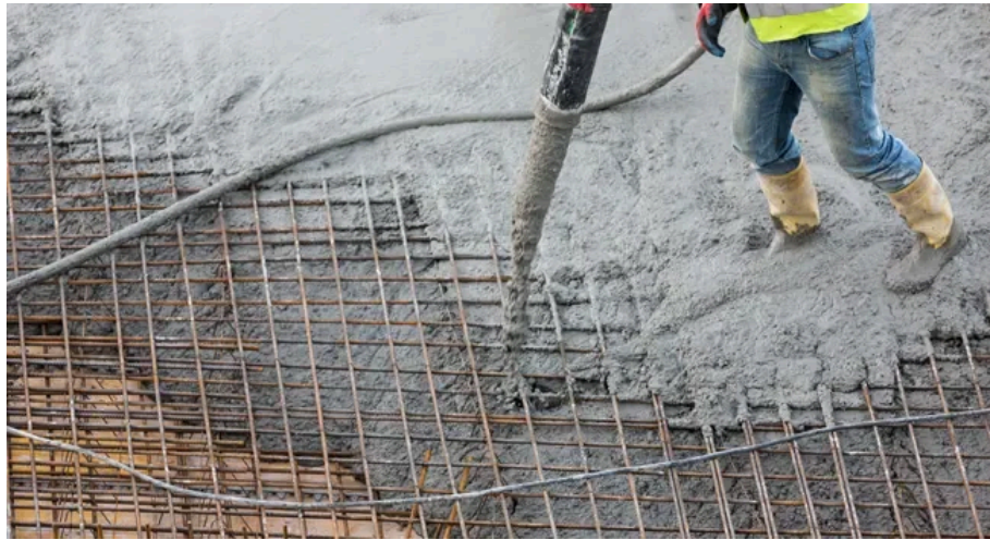
Figura 01 - Estrutura de concreto armado
