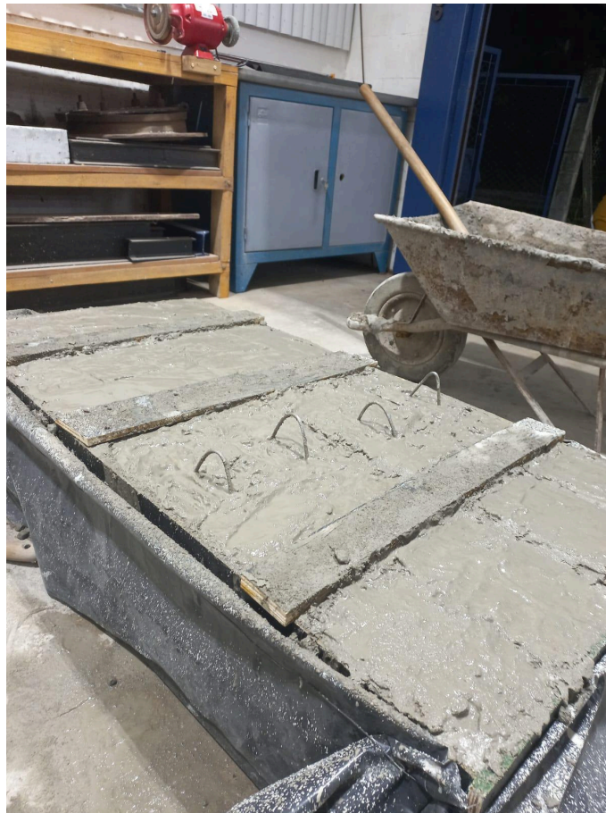
Figura 24 - Concretagem finalizada
