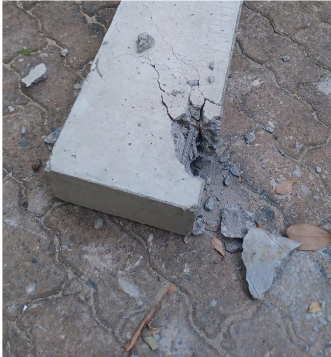
Figura 38 - Viga testemunho rompida por cisalhamento
