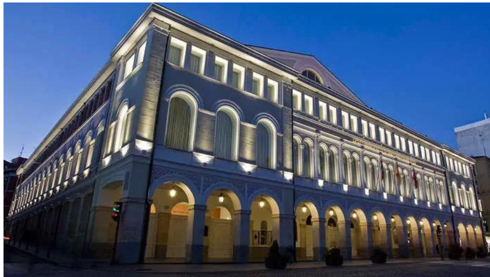
Figura 16: Fachada iluminada no conceito de luz e sombras
