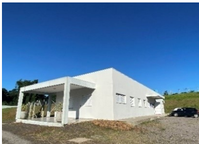
Figura 58- Fachada principal do CBEA
