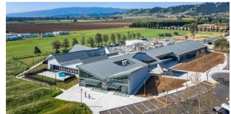
Figura 27- Vista aérea do centro
