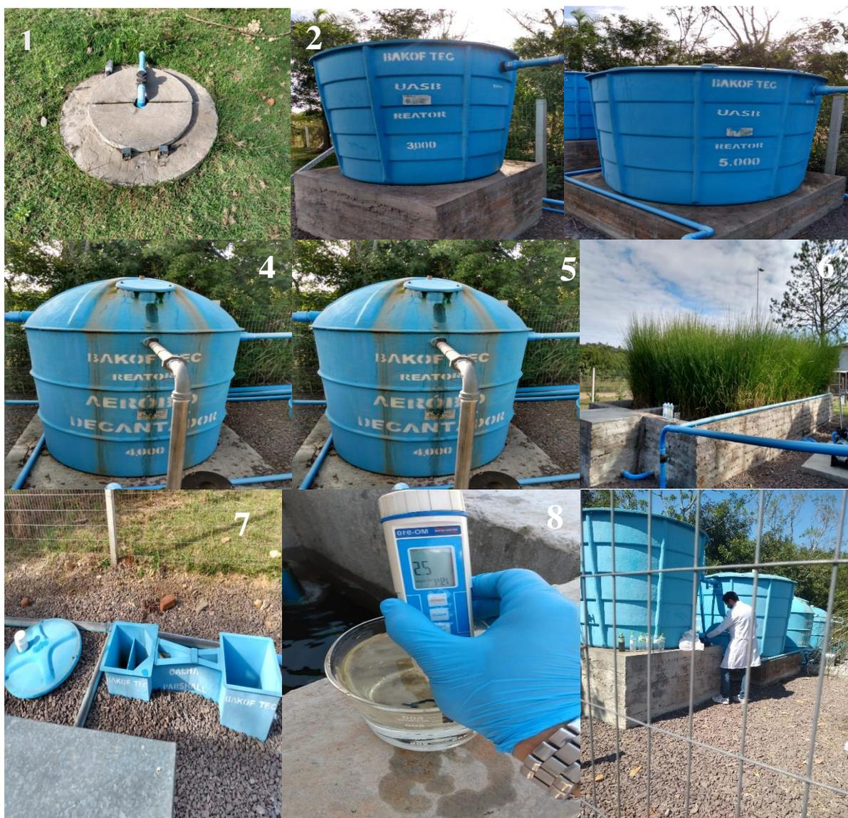
**Figura 2:**Sistema de tratamento de efluentes do Hospital Veterinário Universitário 1-Tanque equalizador ;2- Reator anaeróbico de fluxo ascendente ;3-Sistema Anóxico,4-Decantador Aeróbico; 5-Adensador de lodo;6-*Wetland* ;7-Clorador e Calha;8-Amostragem de oxigênio
