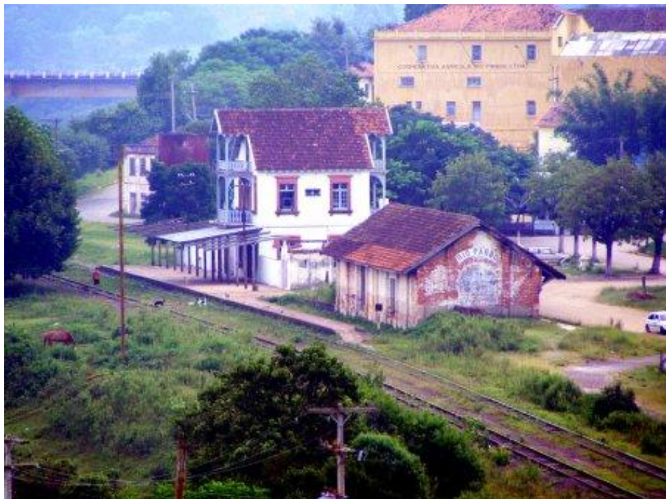
Figura 14 - Estação Férrea de Rio Pardo
