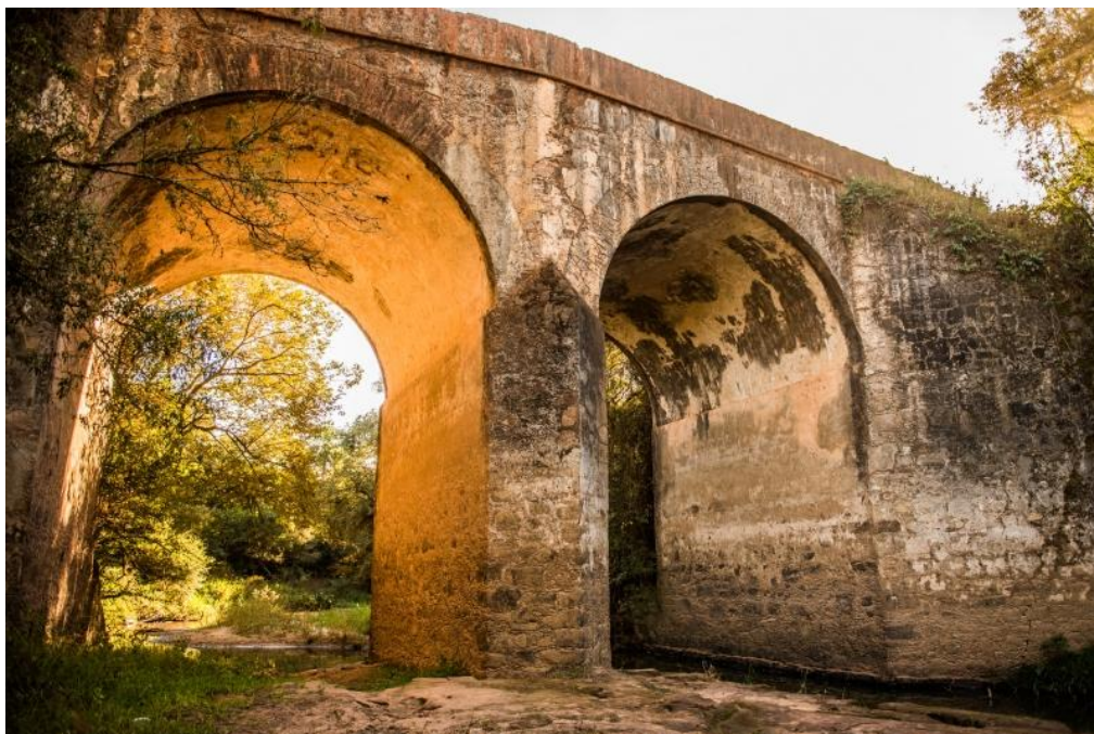
Figura 21 - Ponte do Couto
