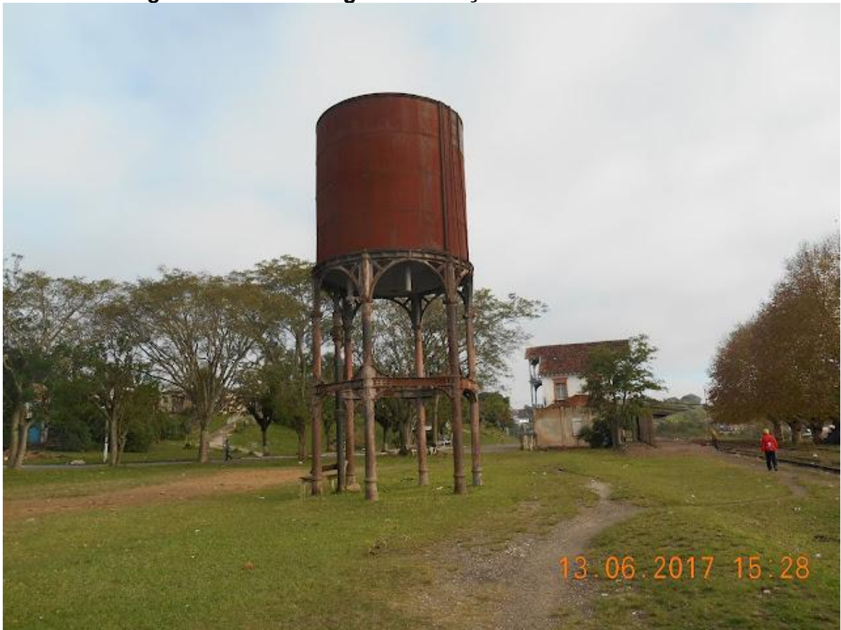
Figura 15 - Caixa d'água da Estação Férrea de Rio Pardo
