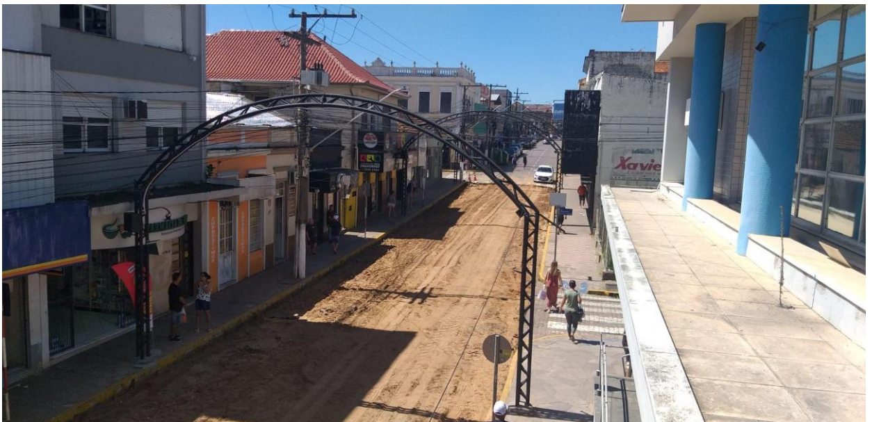
Figura 30 - Troca de pavimentação da Rua Andrade Neves
