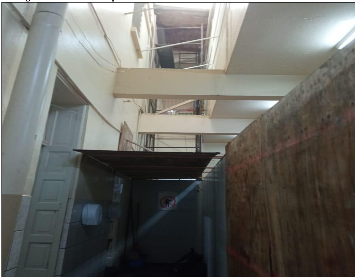
Figura 23 – Parte da dependência da escola colaboradora no momento das obras
