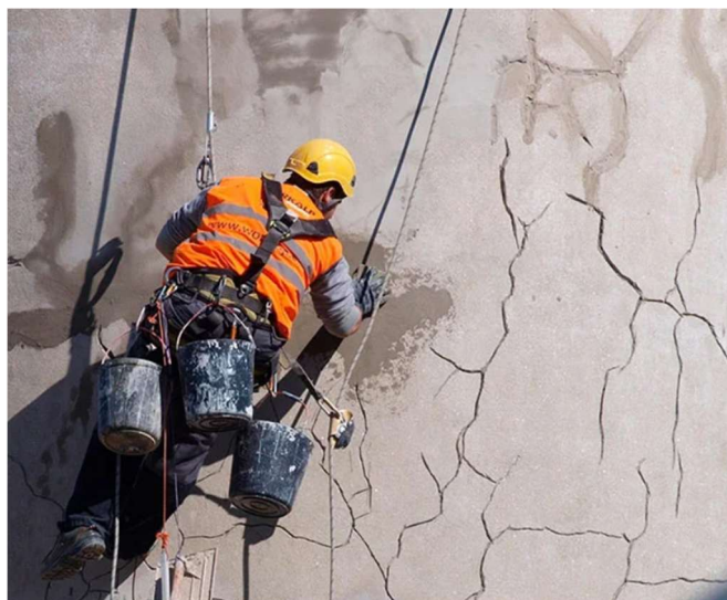
Figura 6 - Processo de mapeamento da fachada
