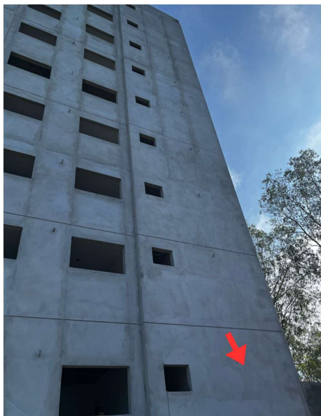
Figura 35 – Parte da vista da fachada Sul: local onde foi realizado os ensaios
