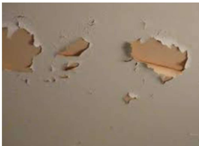
Figura 34 – Descascamento
