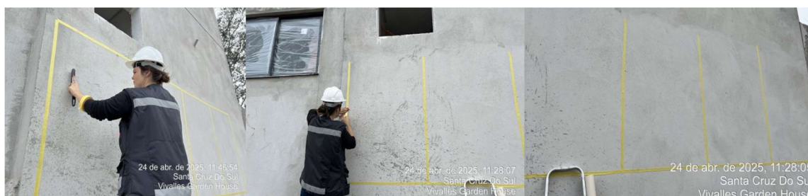
Figura 39 – Processo de colagem das fitas e lixção da superfície
