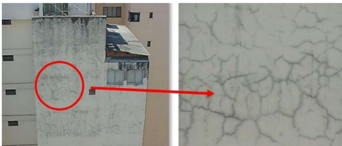
Figura 8 – Fissuras mapeadas
