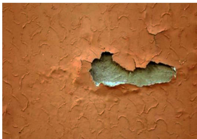
Figura 23 – Desagregamento
