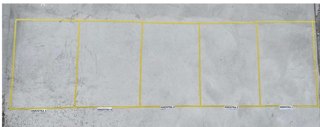
Figura 40 – Pano de fachada demarcado com fita
