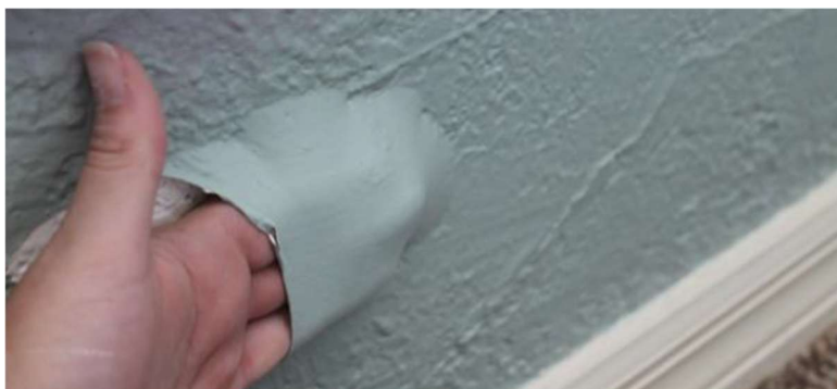
Figura 26 - Bolhas na repintura
