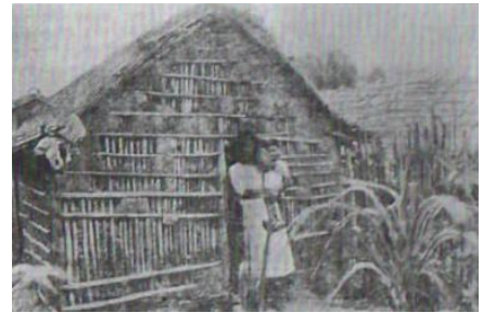
Figura 16- Pau a pique e cobertura de palha
