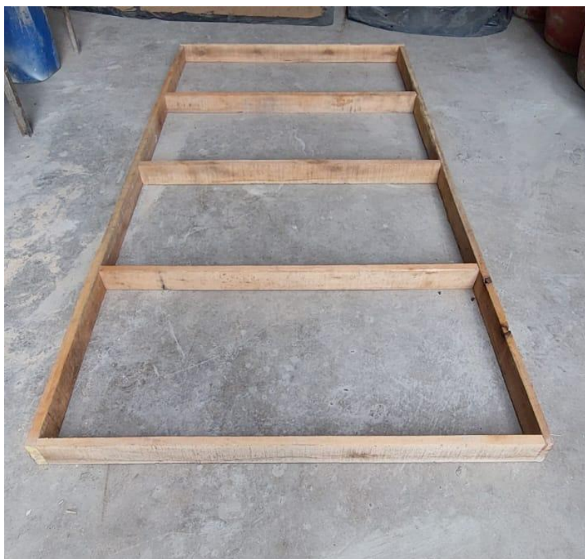
Figura 20 - Montagem das fôrmas
