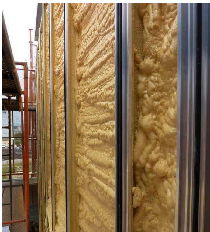
Figura 26 – Isolamento térmico em poliuretano projetado aplicado em fachada
