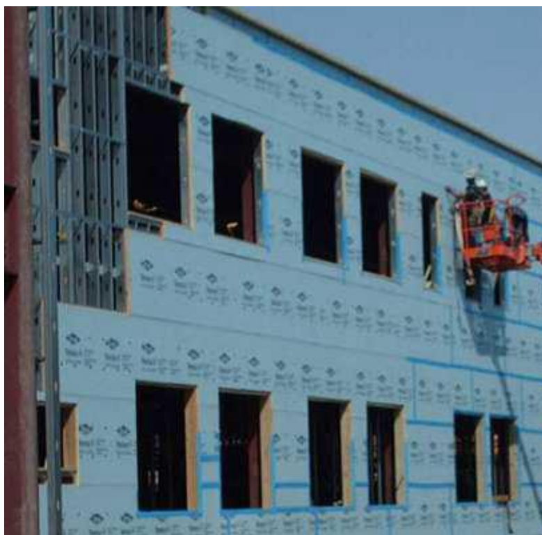
Figura 27 – Isolamento térmico em poliestireno extrudido aplicado em fachada
