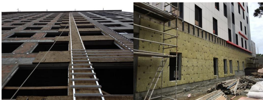
Figura 53 - Aplicação do sistema Ventirock Duo
