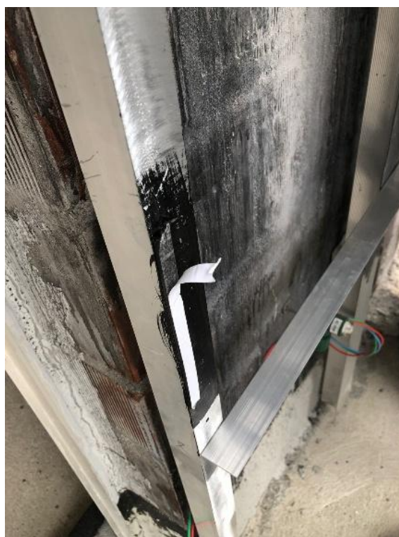
Figura 95 - Aplicação da fita dupla face após a primarização do perfil de alumínio
