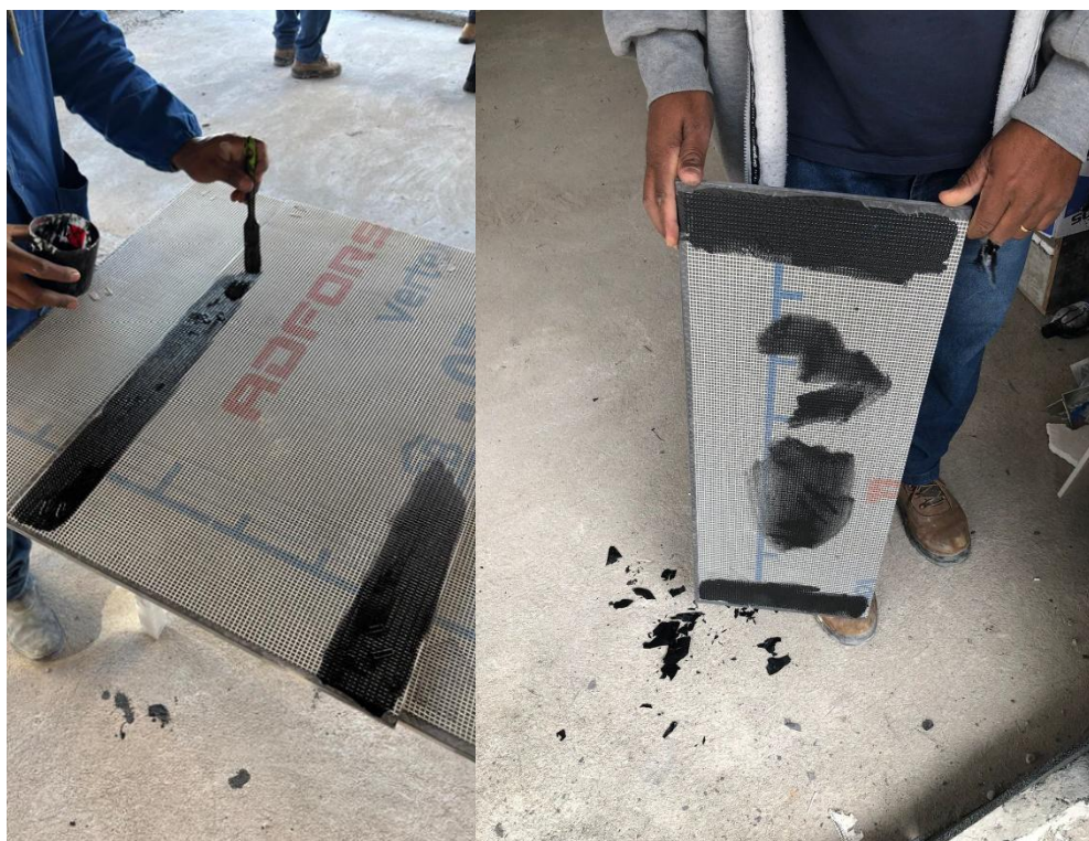
Figura 94 - Aplicação da dupla primarização
