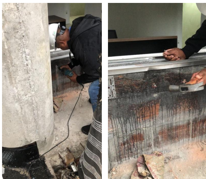
Figura 89 – Furo (esquerda) e fixação (direita) do chumbador mecânico
