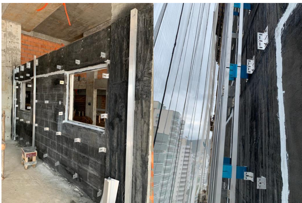
Figura 54 – Aplicação do sistema Ultravent Nano
