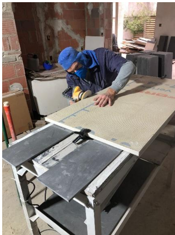
Figura 92 - Lixação das peças com defeito
