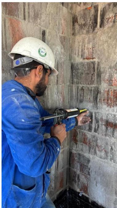
Figura 88 - Fixação do chumbador químico
