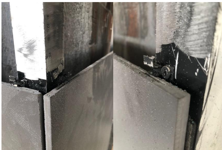
Figura 96 - Encaixe e fixação dos inserts metálicos
