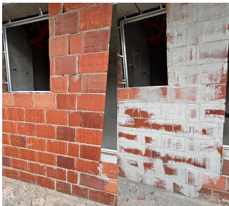
Figura 85 - Antes e depois do tratamento de regularização do substrato
