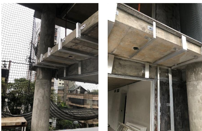
Figura 90 - Perfis metálicos fixados na obra
