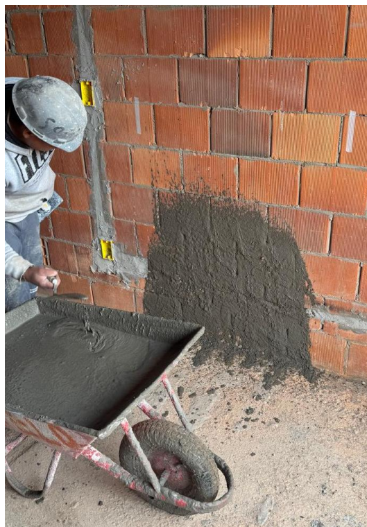
Figura 10 - Aplicação chapisco convencional com colher de pedreiro.
