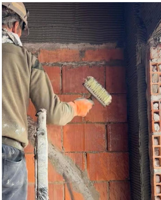
Figura 9 - Umedecimento da parede com trincha.
