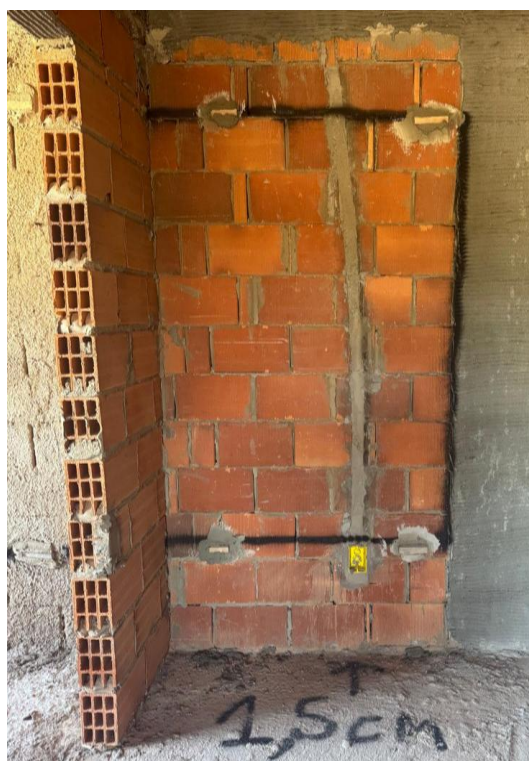
Figura 12 - Taliscamento paredes com cacos de madeira.
