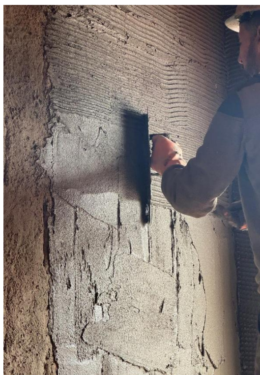
Figura 11 - Aplicação chapisco desempenado com desempenadeira metálica.
