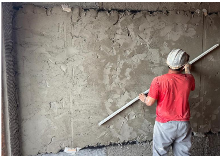
Figura 13 - Sarrafeamento revestimento com régua metálica
