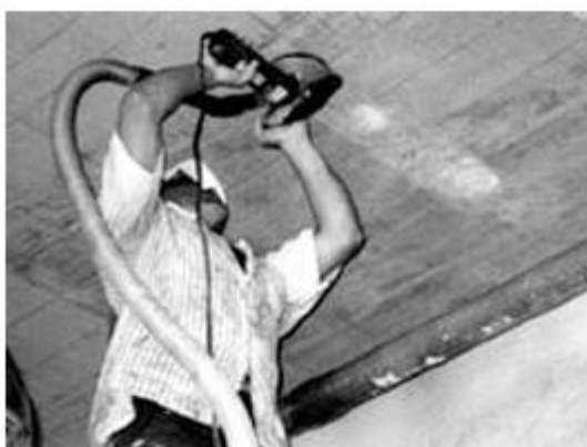
Figura 15 - Utilização de politriz com aspirador para limpeza da superfície
