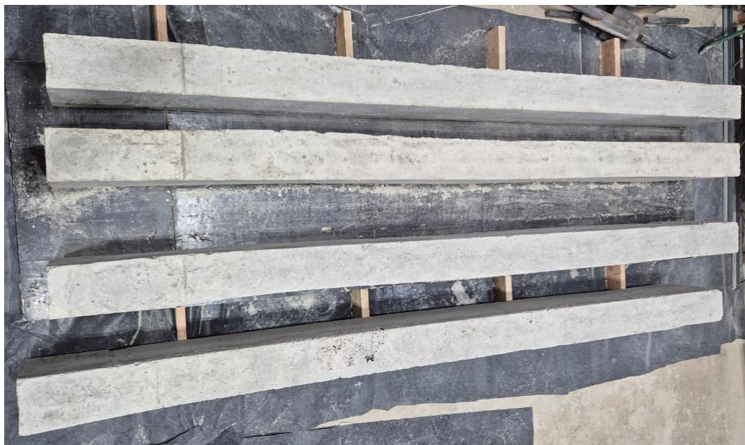
Figura 28 – Elementos após desforma, visualização da integridade
