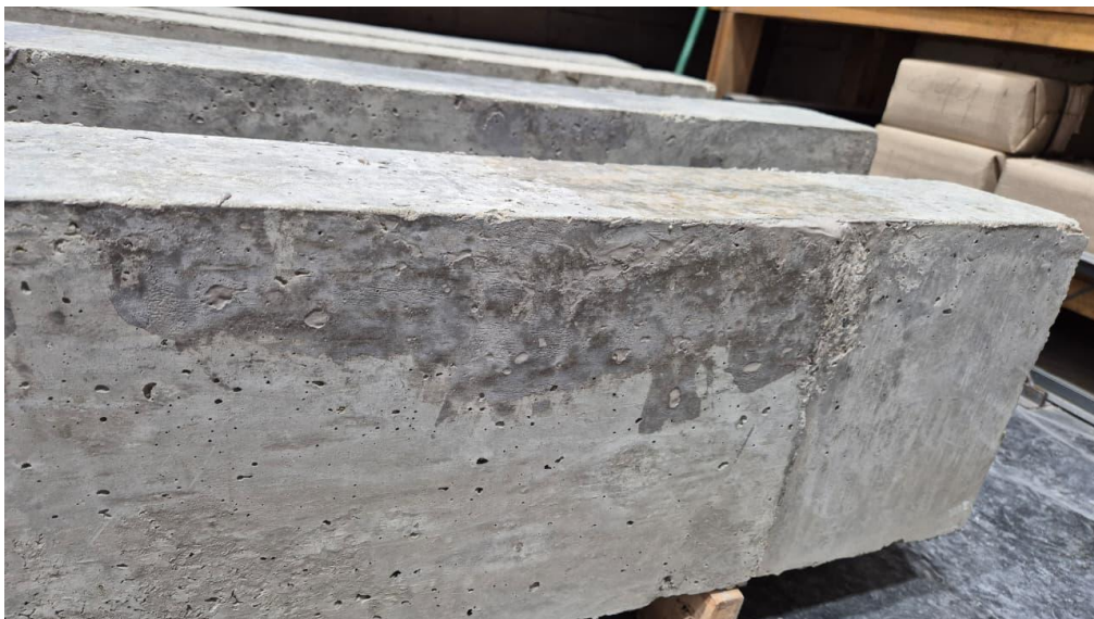
Figura 30 – Orifícios fechados com resina epóxi
