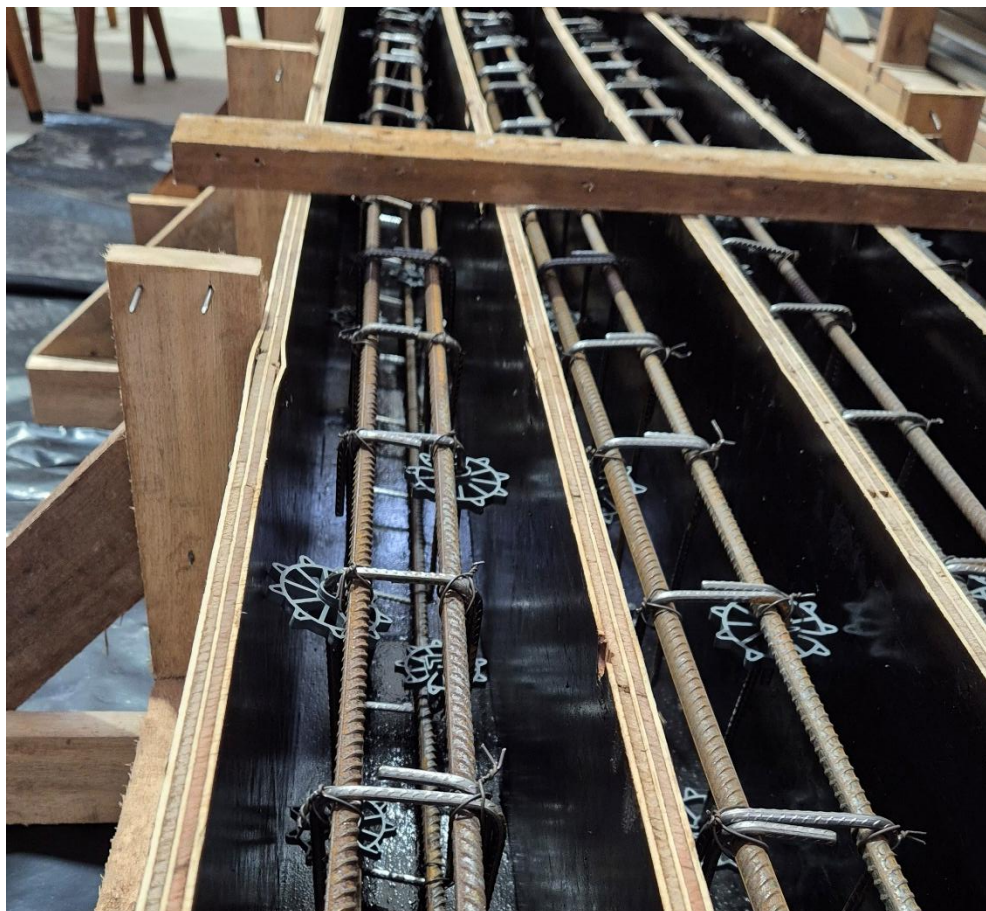
Figura 27 – Armadura com os espaçadores dentro da forma
