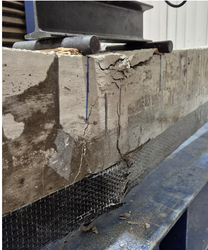
Figura 50 – Viga 3, ruptura do concreto por esmagamento
