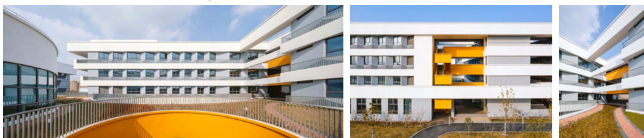
Figura 44: Imagens externas da edificação evidenciando a forma e materialidade da edificação.
