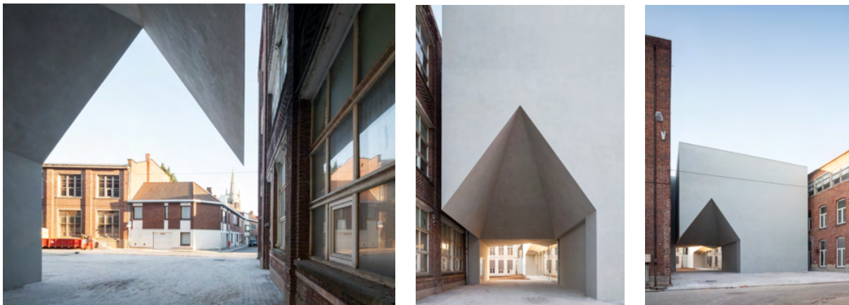
Figura 47: Imagens externas evidenciando o descolamento entre o prédio da faculdade e as edificações já existentes.
