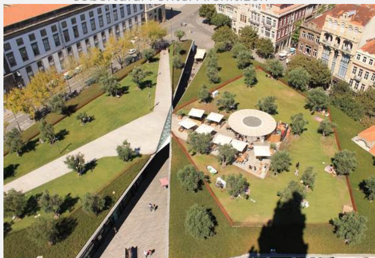
Figura 24 – Perspectiva aérea com foco na cobertura. Fonte: Architizer.
