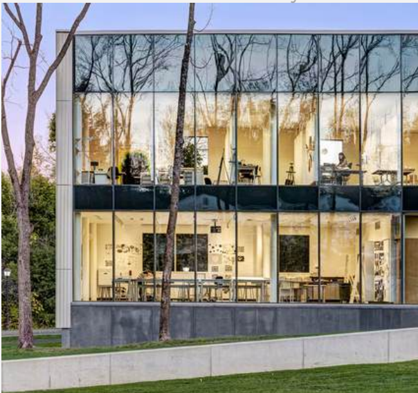
Figura 52 – Fechamento de vidro na fachada. Archdaily.
