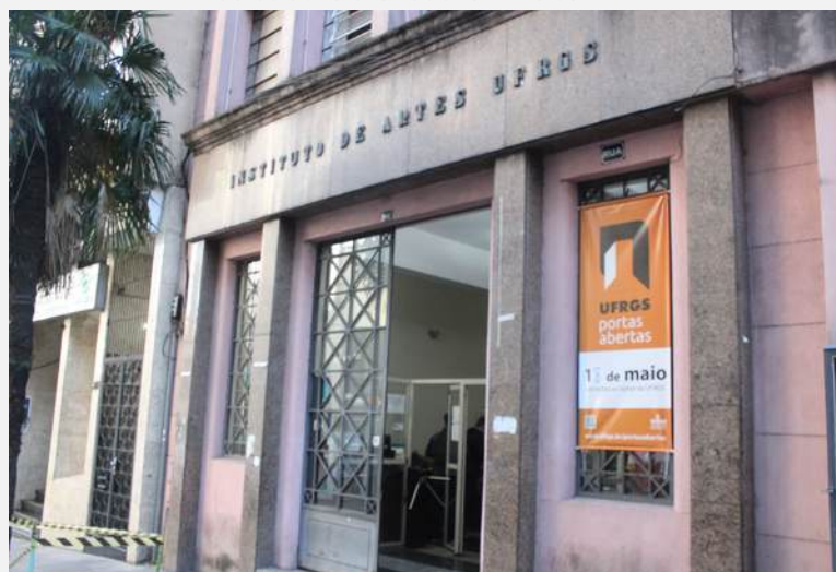
Figura 62 – Foto do acesso do prédio. Fonte: Instituto de artes UFRGS.
